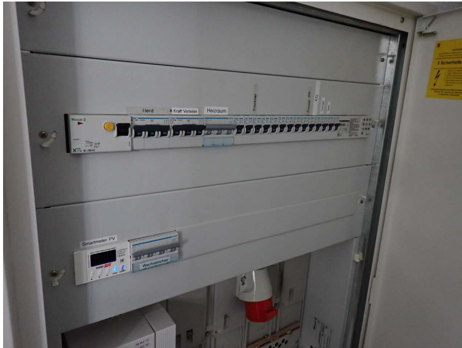
Abbildung 16: Hauptverteiler
