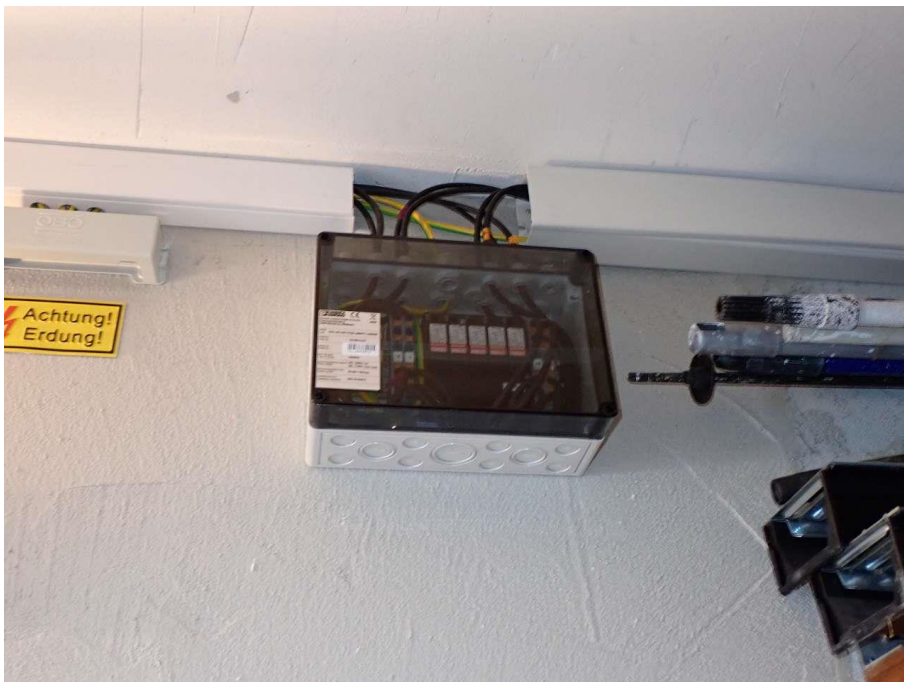
Abbildung 15: Überspannungsbox für 2 Strings
