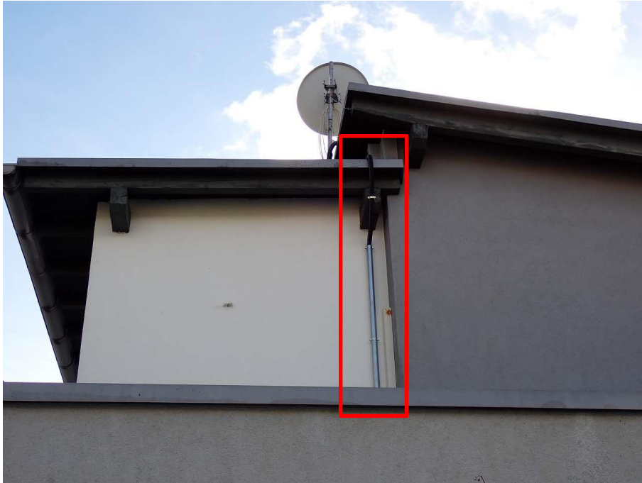
Abbildung 9: Verkabelung an der Außenfassade
