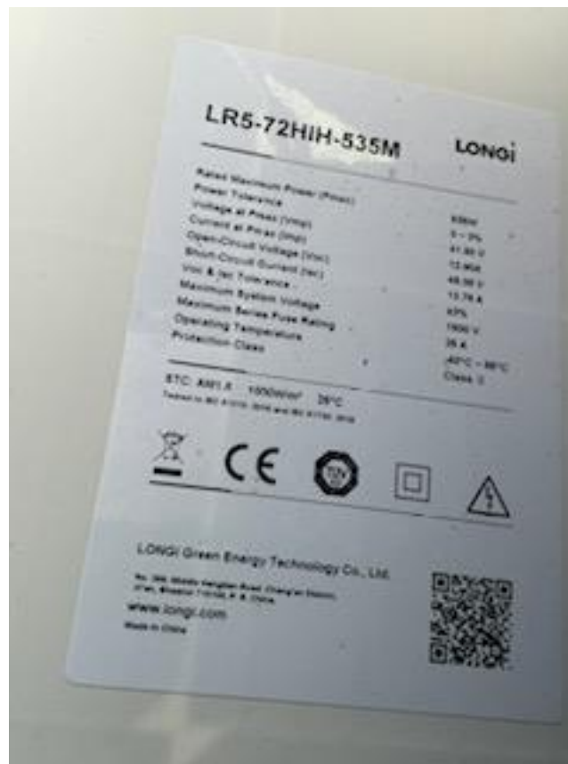
Abbildung 3: Typenschild PV-Modul (Quelle Hr. Zangerle)
