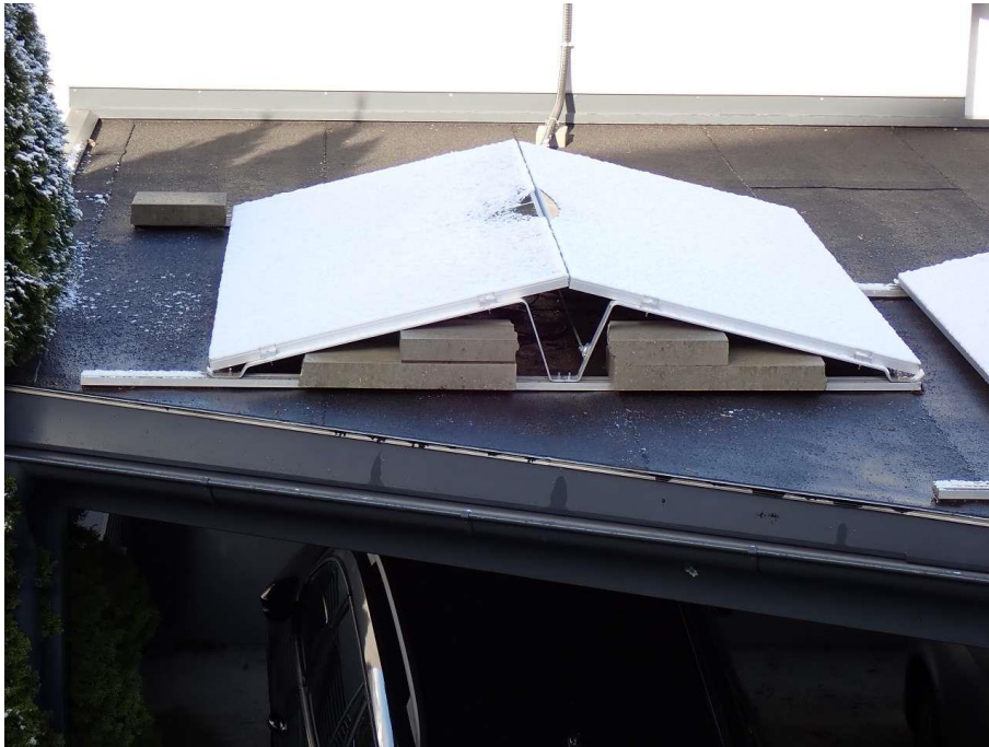
Abbildung 7: Detailansicht Montagesystem mit Ballastierung
