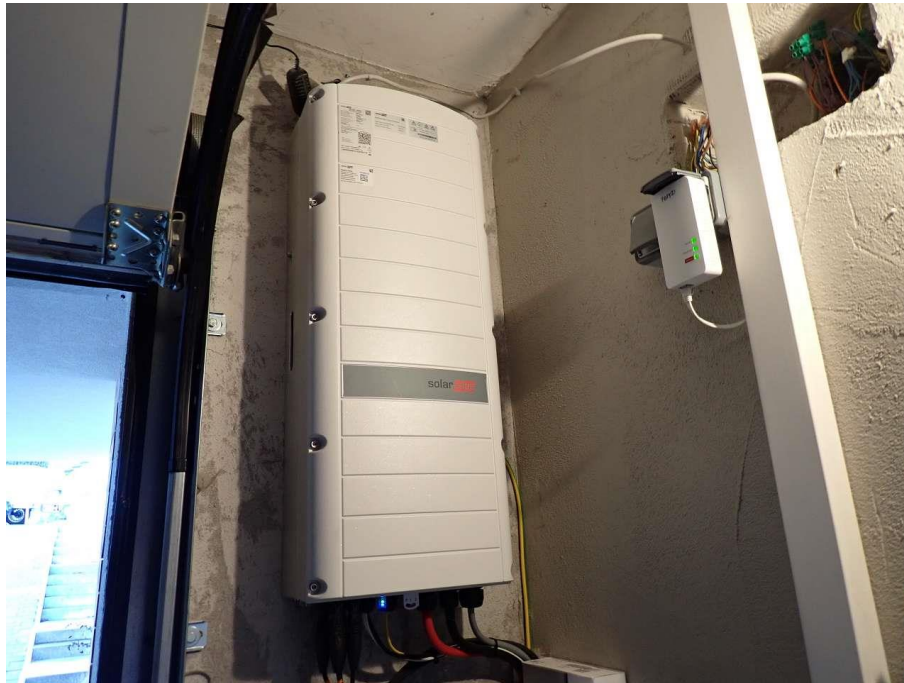
Abbildung 12: Wechselrichter
