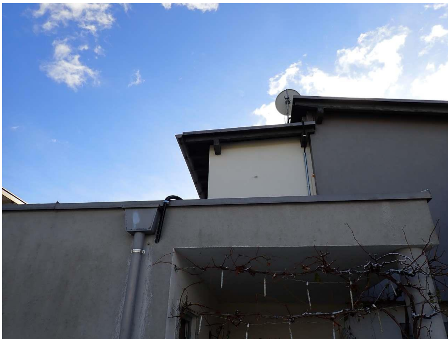
Abbildung 8: Übersichtsbild Fassade (rückseitig)
