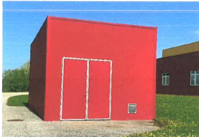
Photo 29: Kläranlagengebäude – Presscontainer – Südansicht
