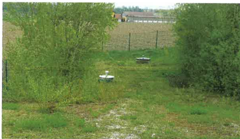
Photo 34: Nordseitiger Eckbereich - Brunnen schacht
