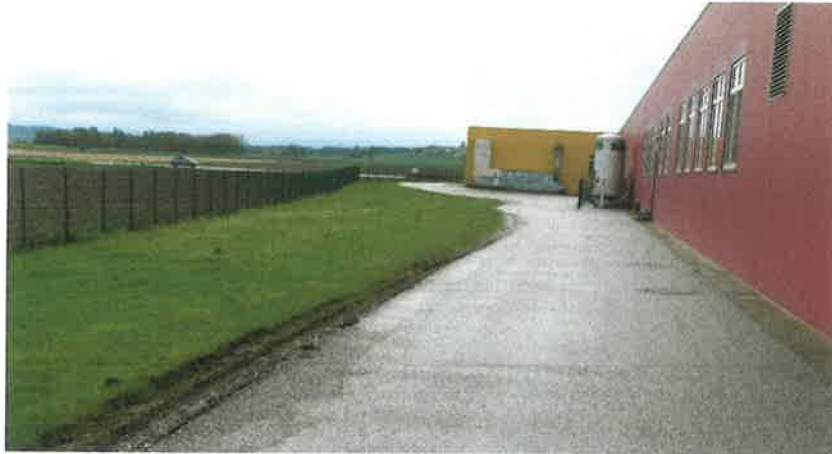
Photo 35: Östliche Längsseite – Blick Richtung Süden
