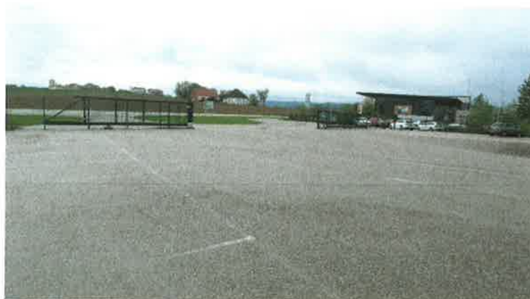
Photo 31: Einfahrtsbereich – mit Blick auf die Landesstraße
