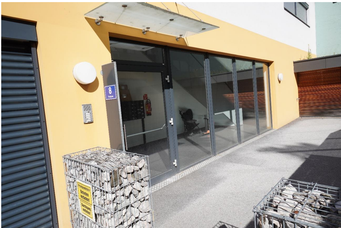
Außenansicht Zugangsbereich EG
