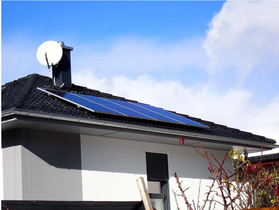
Abbildung 7: Dachfläche Ost (4 Module)
