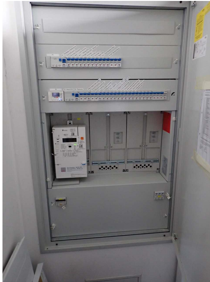
Abbildung 12: Hauptverteiler
