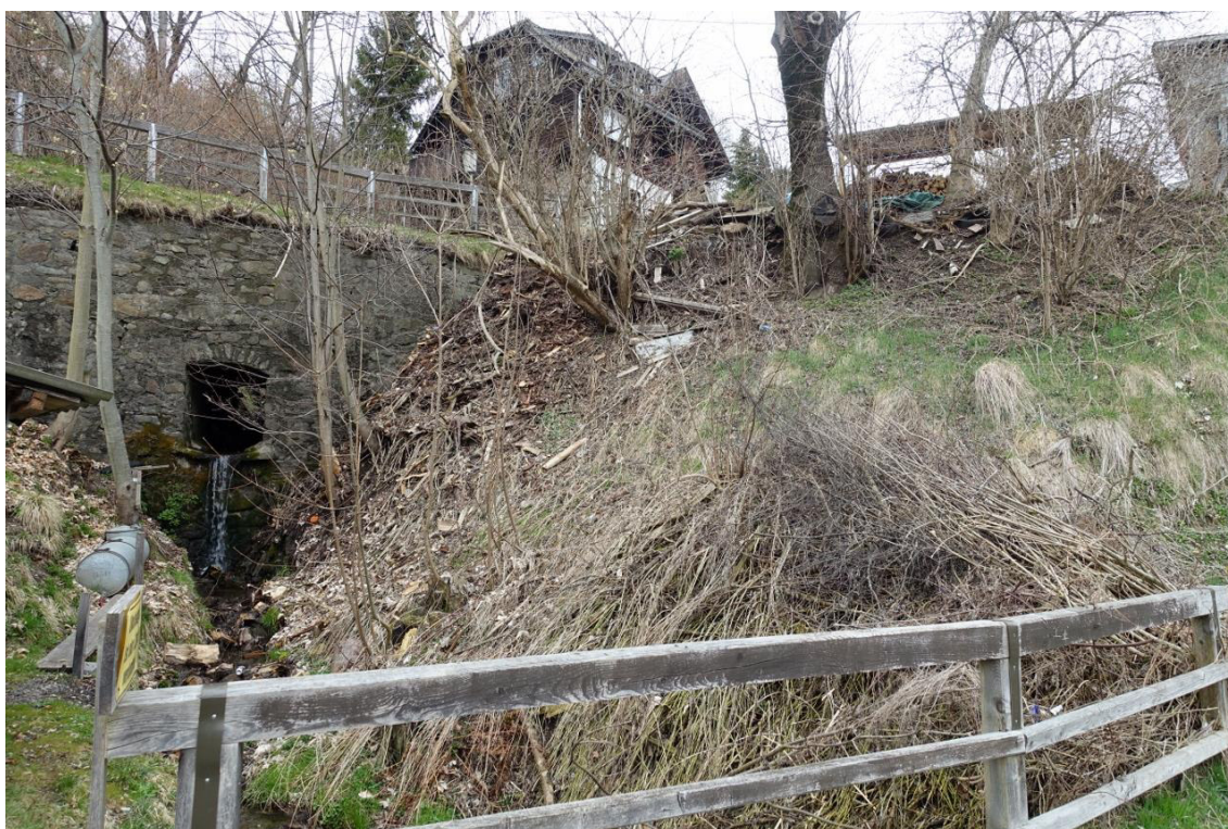
NORDWESTLICHE BÖSCHUNGSFLÄCHE - FOTO 84
