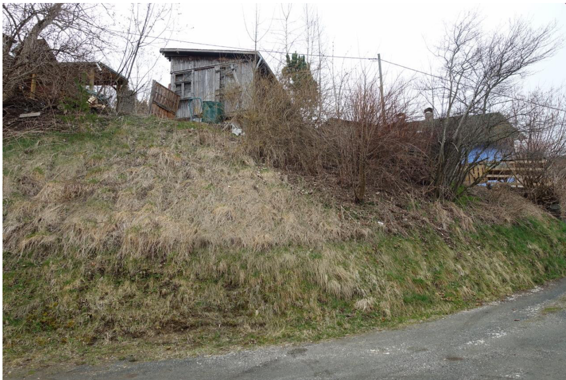
NORDWESTLICHE BÖSCHUNGSFLÄCHE - FOTO 83
