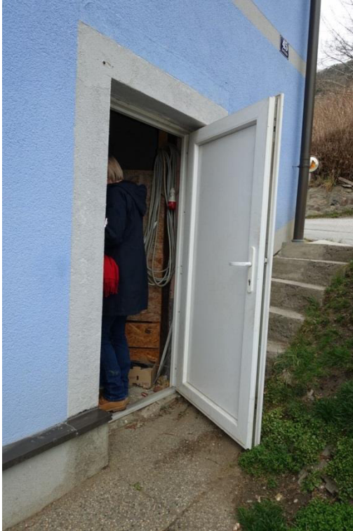
EINGANG HOLZL./HEIZRAUM - FOTO 32
