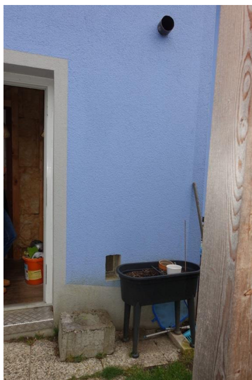
ZU- UND ABLUFT/SELCH - FOTO 27
