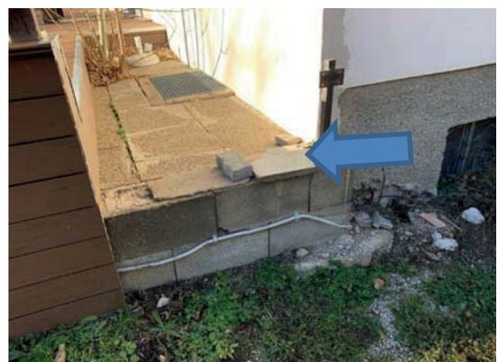
Bild 96: Bef. Fläche zwischen Terrasse und Hausmauer – lose und uneben
