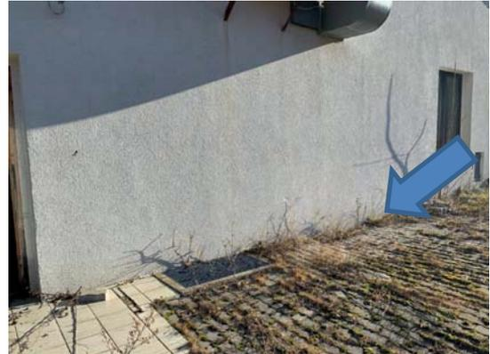
Bild 92: westliche Fassade – aufsteigende Feuchtigkeit
