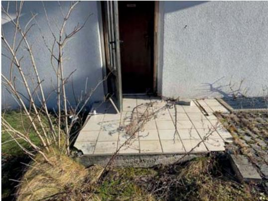
Bild 97: Nebeneingang – Fliesen beschädigt, Pflastersteine lose
