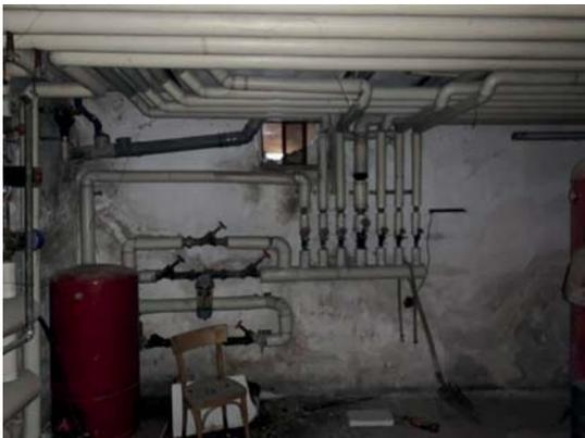
Bild 105: Keller – Wände durchfeuchtet
