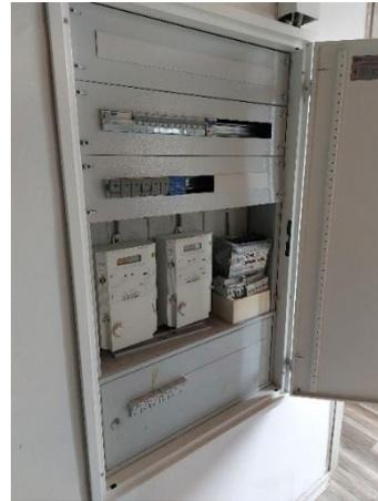
Abbildung 29 Stromkreisverteiler
