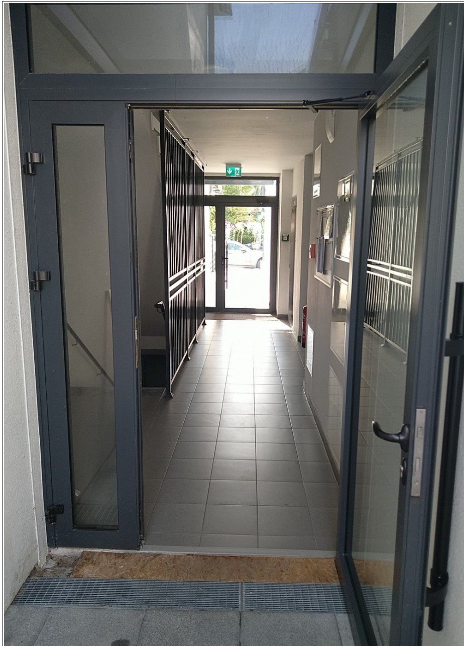
Bild_15: Ansicht / Übersicht Eingangstüre (alle 4 Türen sind baugleich)
