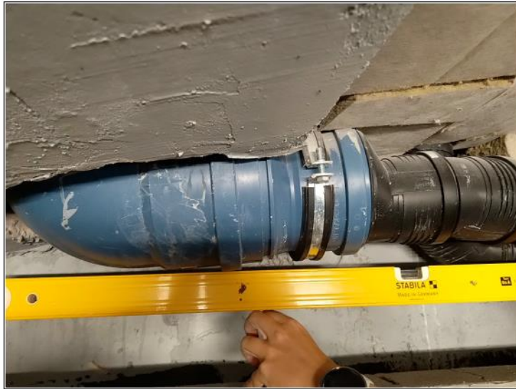
Bild_19: Rigol Einfahrt von unten / Gegengefälle !!!
