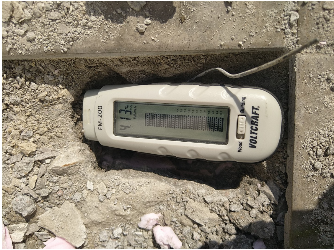
Bild_08: Gefällsbeton unter Verbundabdichtung NASS
