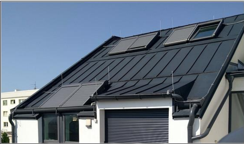
Bild_01: Übersicht Blechdach Trakt MTG
