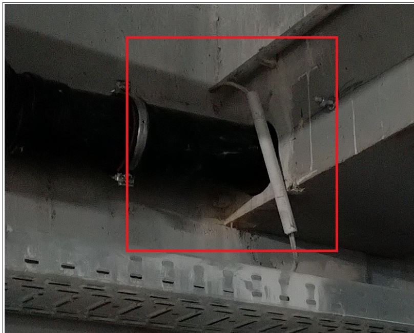
Bild_25: Nachträglich durchbohrter Unterzug (Garage)
