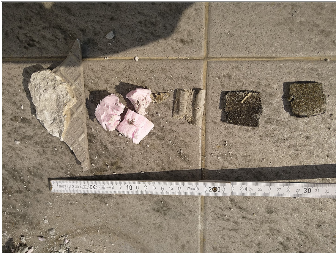
Bild_07: Schichtaufbau Bslkon (hier Top 09 / MTG, Bauteilöffnung am 15.08.2025)
