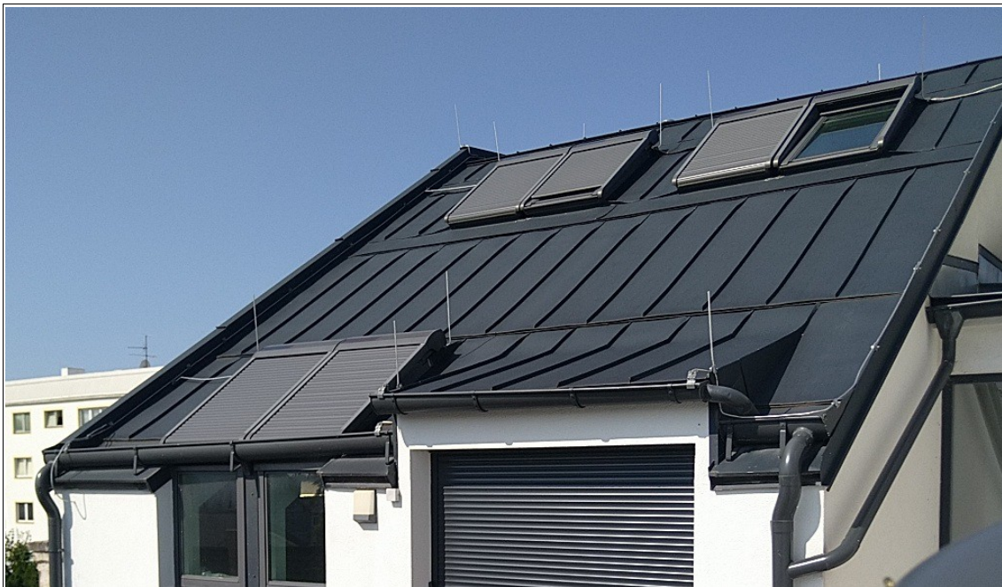
Bild_01: Übersicht Blechdach Trakt MTG
