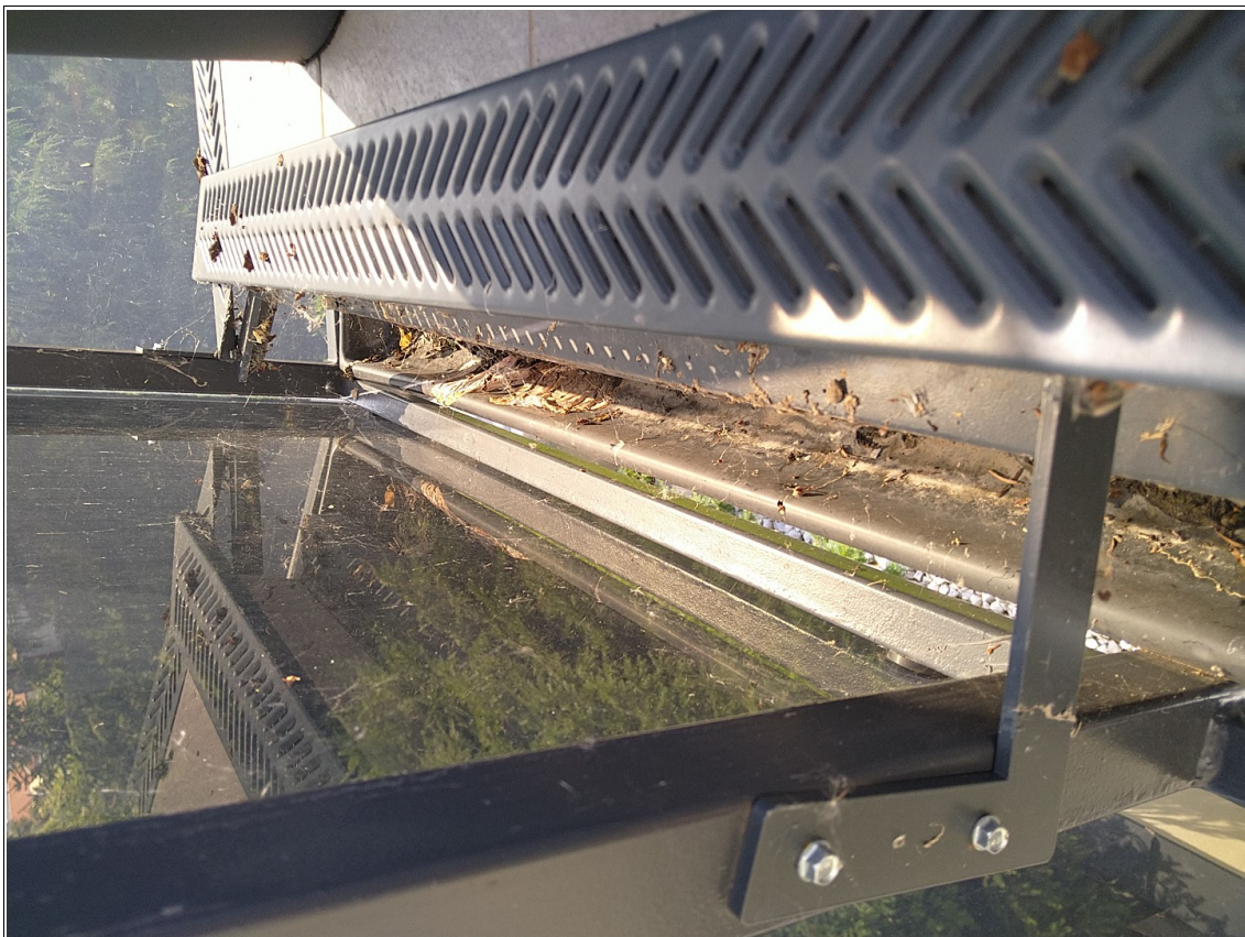
Bild_14: fehlende Auflagepunkte der Abdeckroste
