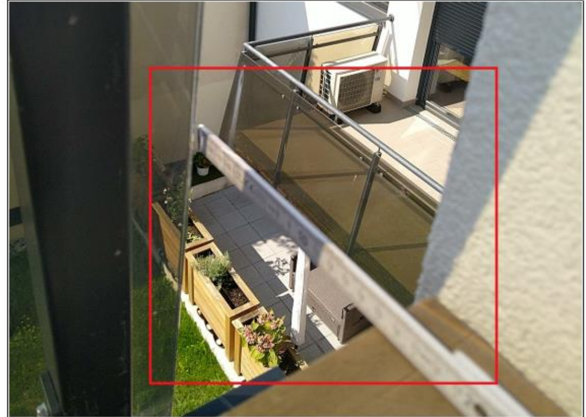
Bild_13: das Glas kragt von der Fassade bis zu 15cm aus
