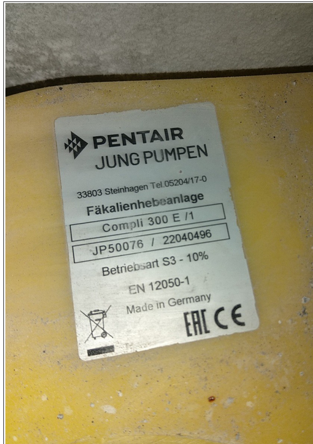
Bild_22: Typenschild Hebeanlage
