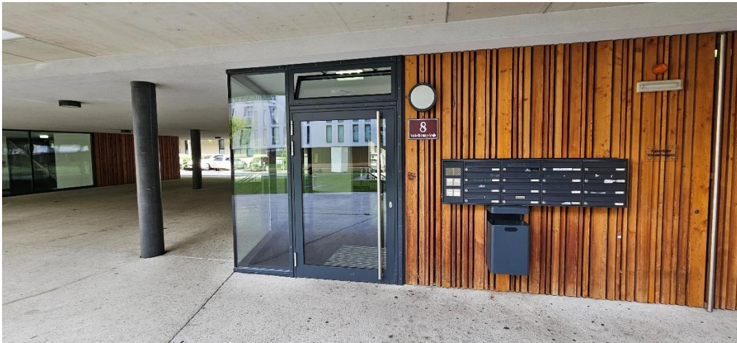
Abbildung 3 – Ansicht Hauseingang Nr. 8
