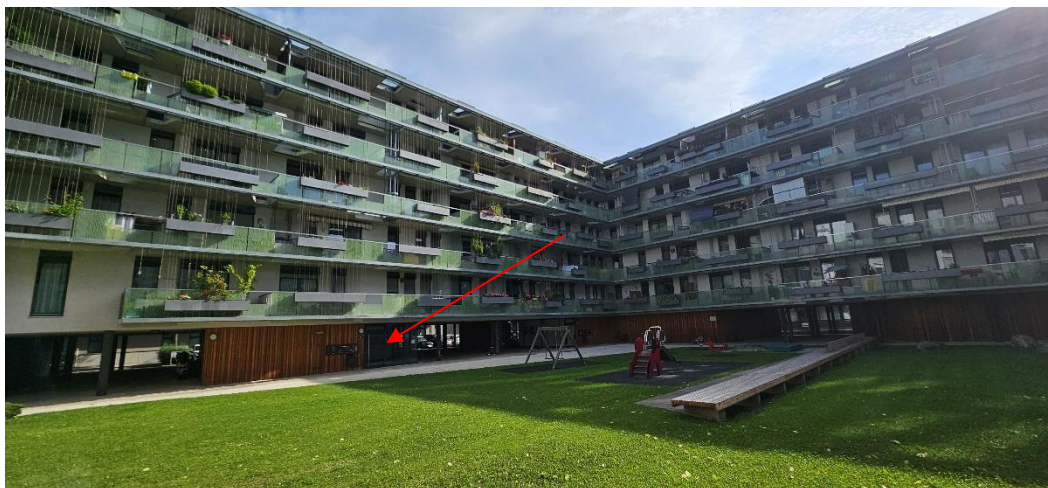
Abbildung 2 – Ansicht Innenhof Nord-Ost
