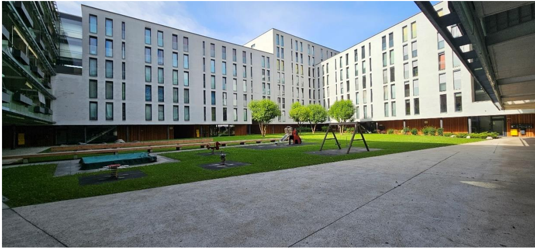
Abbildung 1 – Ansicht Innenhof Süd-West
