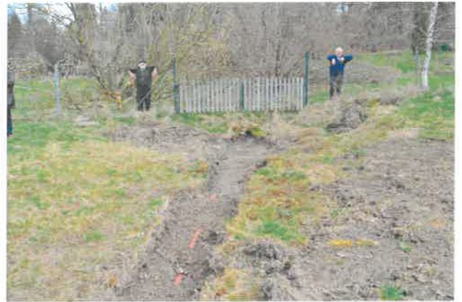
Ablauf Teich / Tonrohre / Alte Drainage
