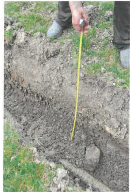
Ableitung Drainage (70-80 cm tief)
