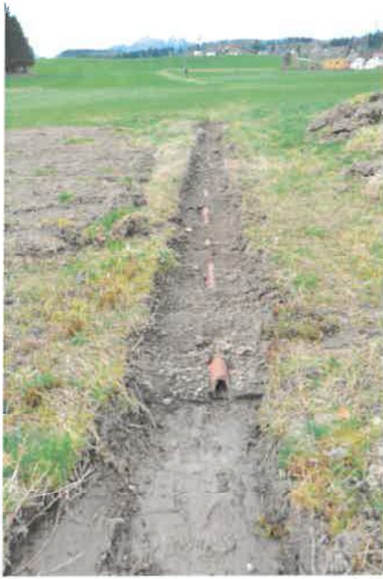
Ablauf Teich / Tonrohre / Alte Drainage
