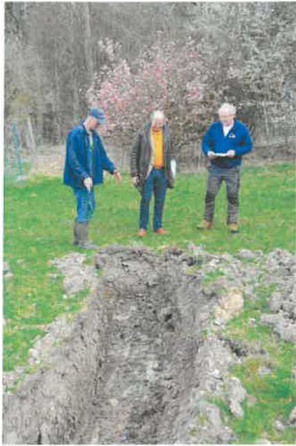
Ableitung Drainage (70-80 cm tief)
