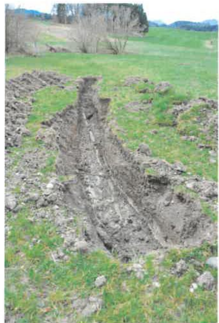
Ableitung Drainage (70-80 cm tief)
