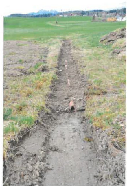
Ablauf Teich / Tonrohre / Alte Drainage
