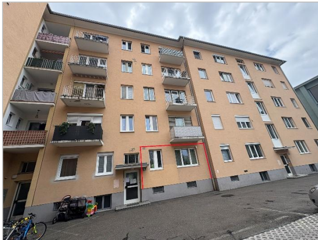
Ansicht hofseitig (westseitig)
