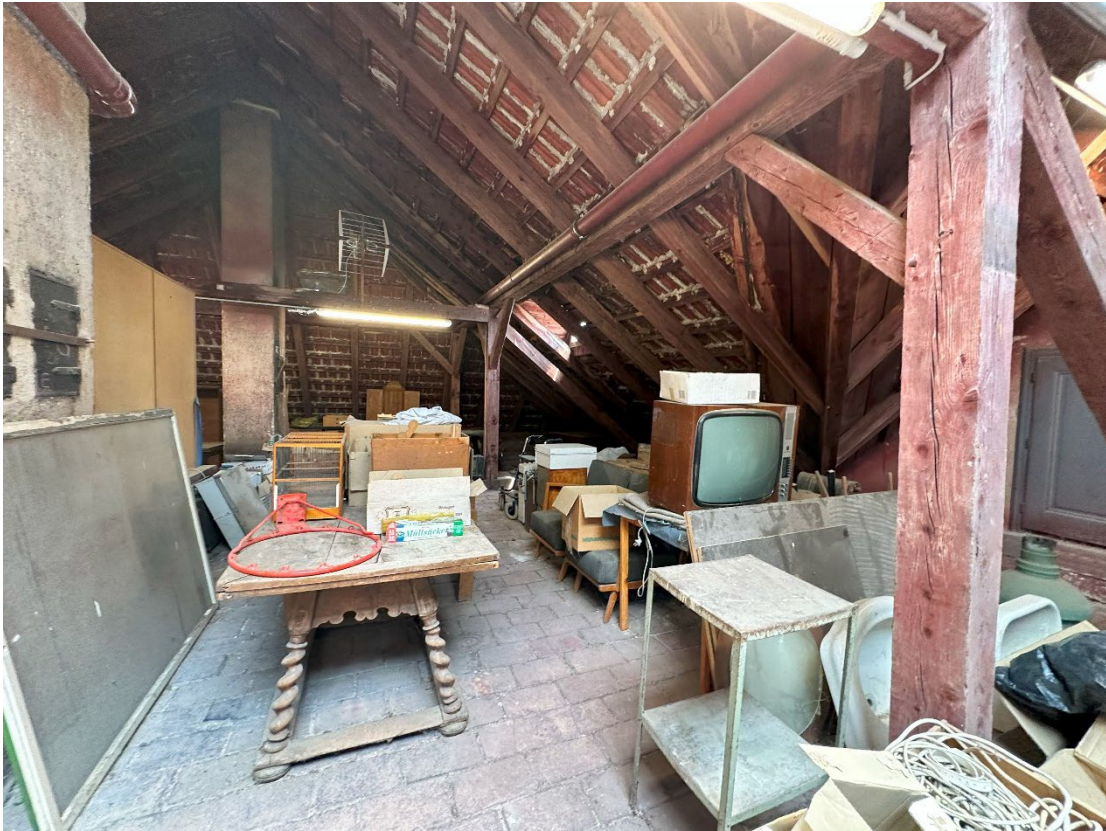
Foto 93: nicht ausgebautes Dachgeschoß
