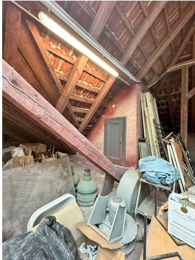
Foto 91: nicht ausgebautes Dachgeschoß
