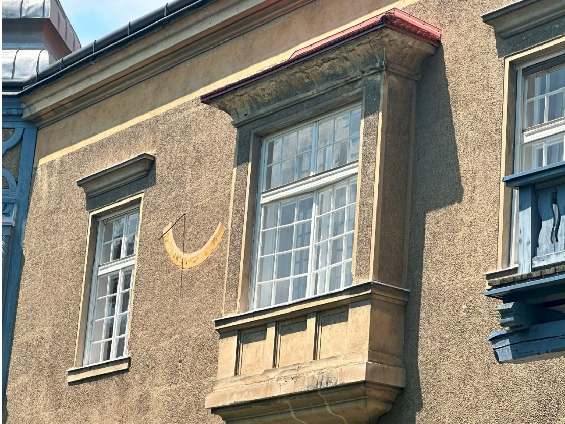
Foto 57: Fassade mit Sonnenuhr | Südansicht
