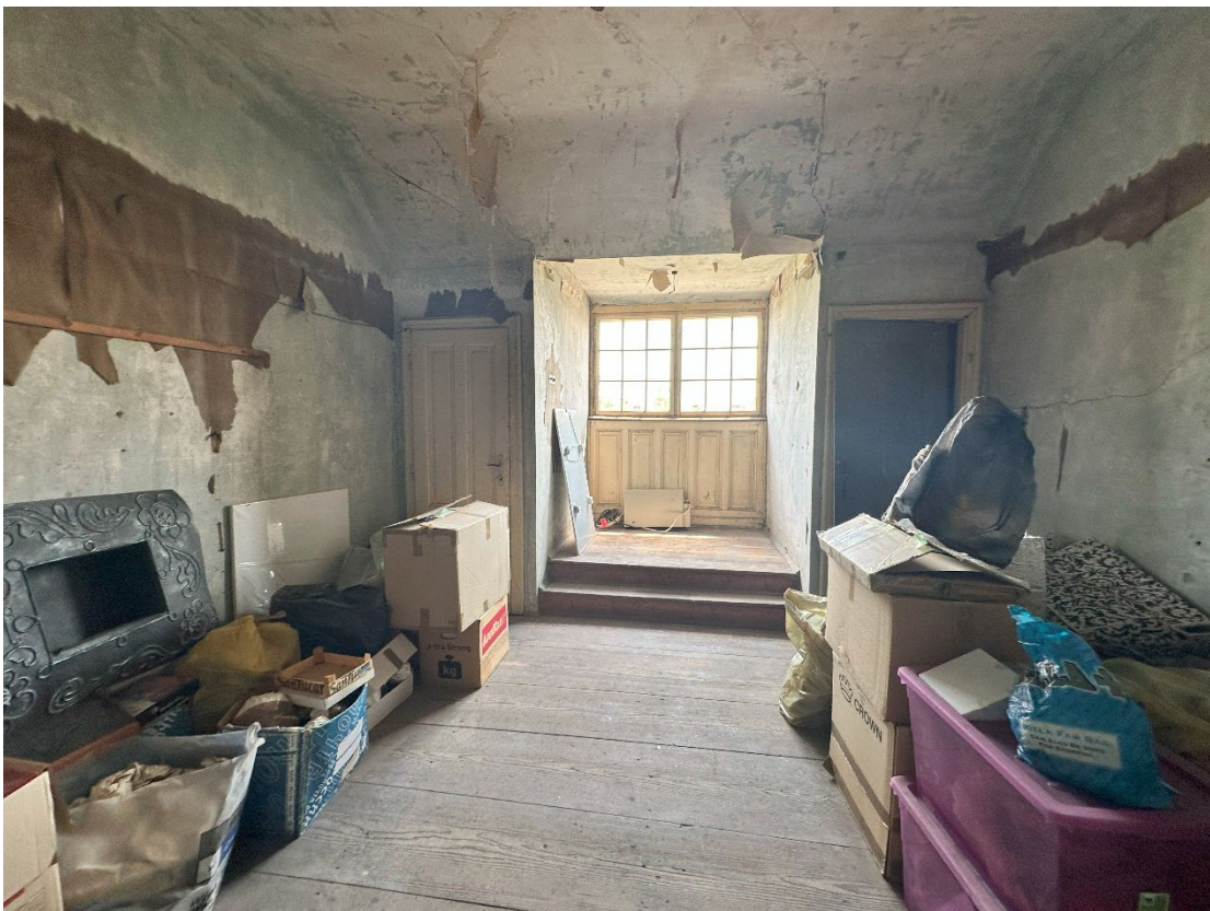
Foto 94: Gaupe | nicht ausgebautes Dachgeschoß
