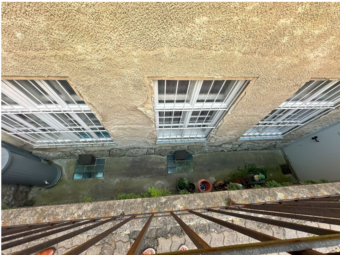
Foto 30: Blick in den Hof
