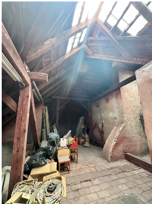
Foto 90: nicht ausgebautes Dachgeschoß
