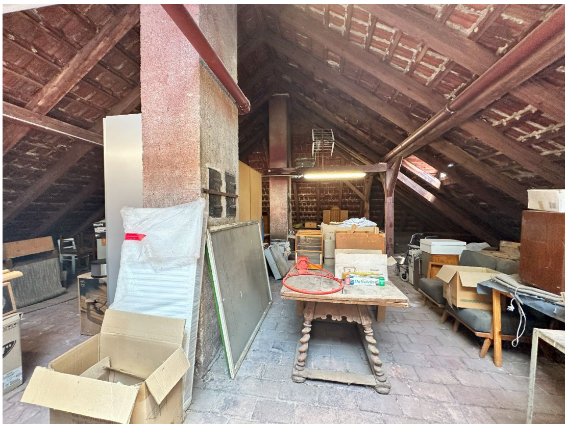
Foto 92: nicht ausgebautes Dachgeschoß
