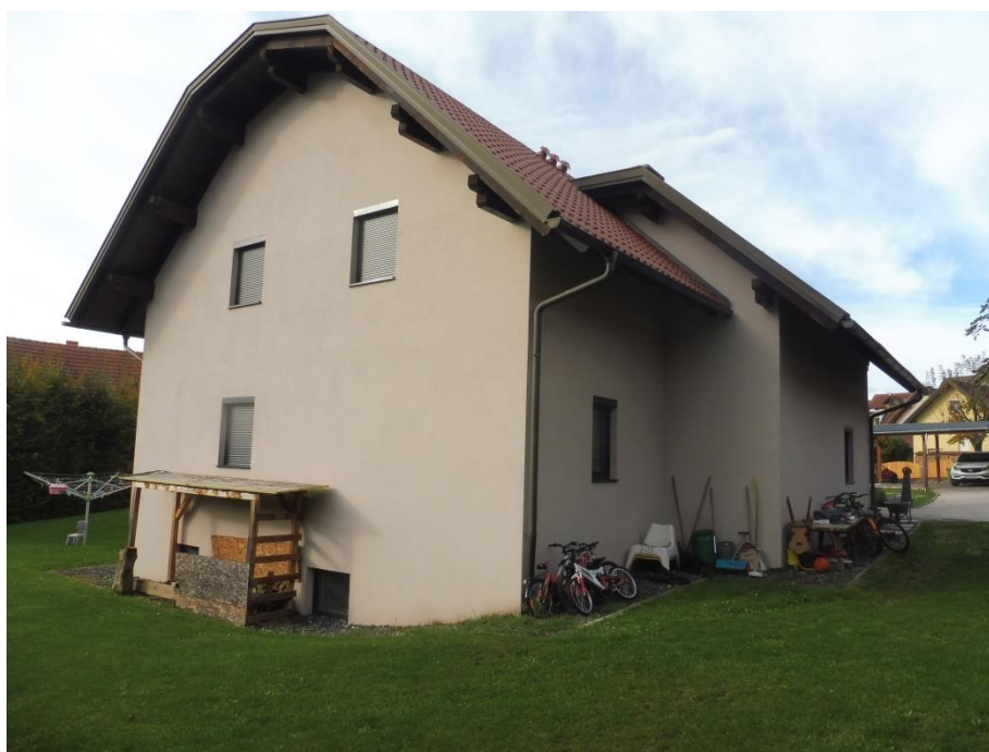
Nord- und Ostseite (oben)
