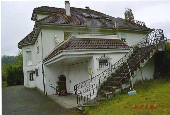
Nordwestansicht Eingang EG
