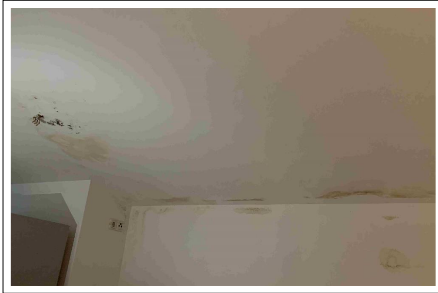
Diverse Wasserschäden
