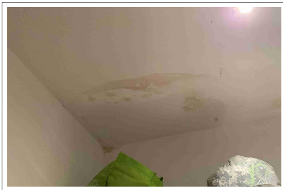
Diverse Wasserschäden
