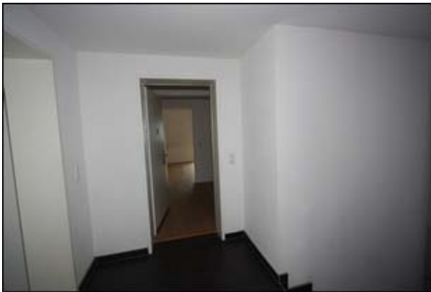
Abb.23 Ansicht Flur DG, Eingang Wohnung (Top 7 Penthouse 1)
