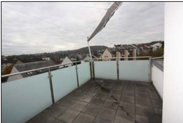
Abb.65 Ansicht Dachterrasse (Empore)
