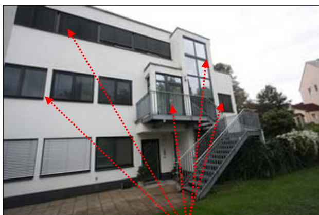
Abb.72 Ansicht Hofgebäude, westlicher Teilgebäudeteil Lage Wohnung Einheit 13 Top H04 (1./2.OG), Außenstiege
