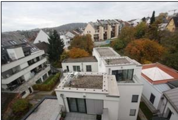
Abb.35 Ansicht Aussicht von der Terrasse (DG) auf Hofgebäude
