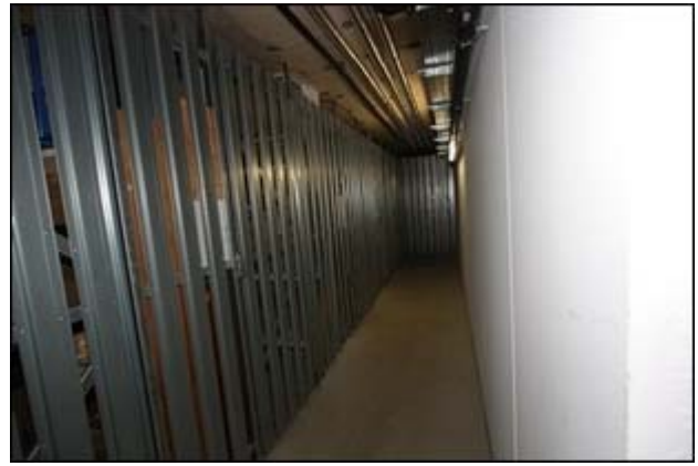
Abb.68 Ansicht Bereich Kellerabteile
