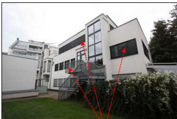
Abb.70 Ansicht Hofgebäude, westlicher Gebäudeteil Lage Wohnung Einheit 13 Top H04 (1./2.OG)
