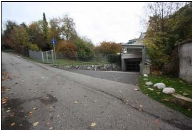
Abb.11 Ansicht Liegenschaft Westseite, Zufahrt TG
