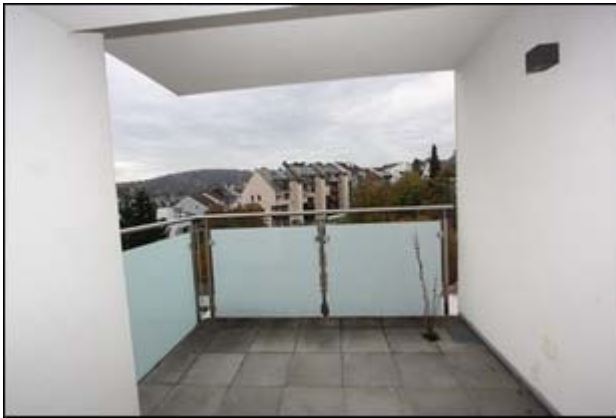
Abb.33 Ansicht überdachte Dachterrasse (DG)
