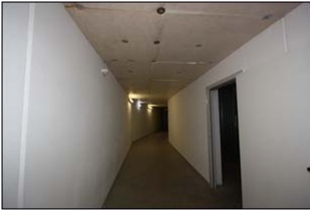
Abb.67 Ansicht Verbindungsgang KG (Bereich Kellerabteile) (Dieser Gang stellt auch die Verbindung zwischen dem Gebäude Hauptstr. 63 (Vorderhaus) und die Tiefgarage dar)
