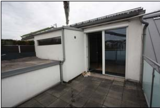
Abb.63 Ansicht Dachterrasse (Empore)
