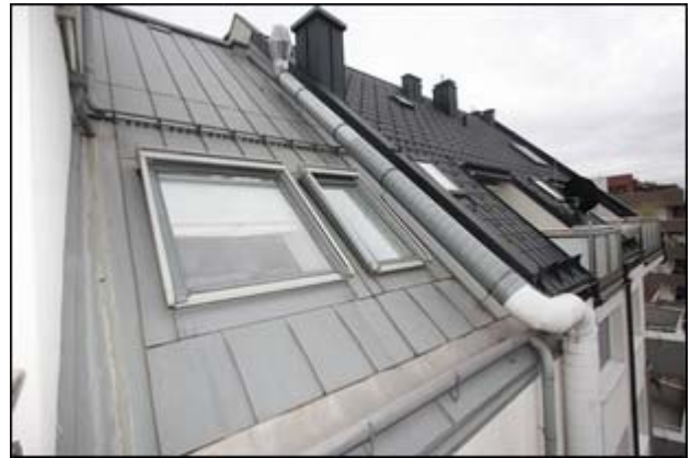
Abb.34 Ansicht südl. Dachlandschaft (von der Terrasse aus)
