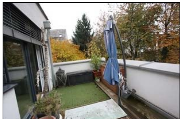
Abb.89 Ansicht Dachterrasse West (vgl.Abb.71, 2.OG)
