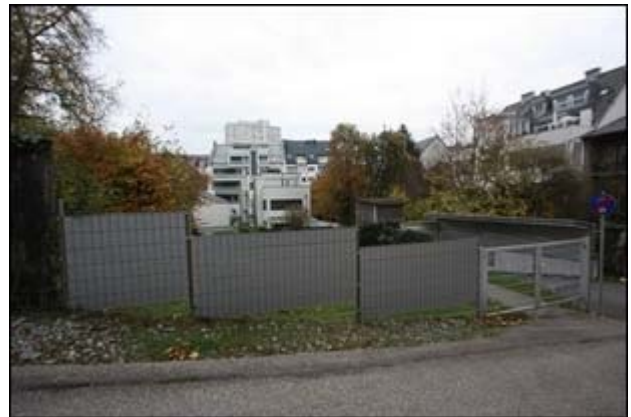
Abb.12 Ansicht Einzäunung Liegenschaft Westseite, Gartentor
