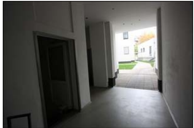
Abb.18 Ansicht Vorderhaus (EG), Durchgang, Richtung Hofgeb.
