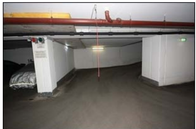
Abb.102 Ansicht Erschließung TG, Ein-/Ausfahrt TG-Ebene links: Abstellplätze an der Südseite (Nr. 15-18)
