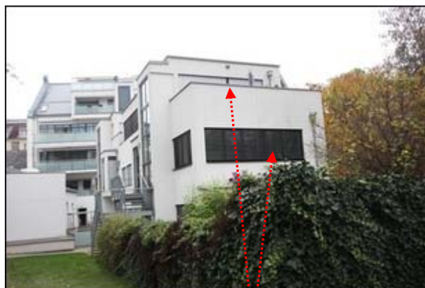
Abb.71 Ansicht Hofgebäude, westlicher Gebäudeteil Lage Wohnung Einheit 13 Top H04 (1./2.OG)
