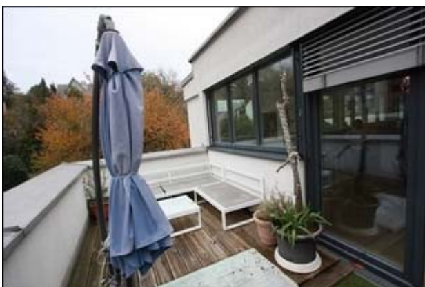
Abb.88 Ansicht Dachterrasse West (vgl.Abb.71, 2.OG)
