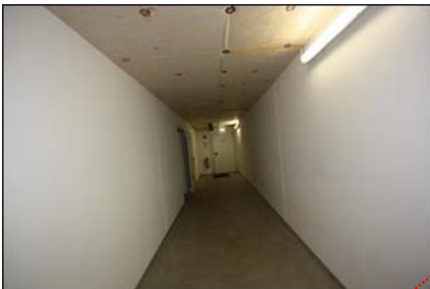
Abb.94 Ansicht Verbindungsgang KG (Bereich Kellerabteile) (Gehverbindung Wohnung Top H04 via TG (vgl. Abb.7, 97, 98))
