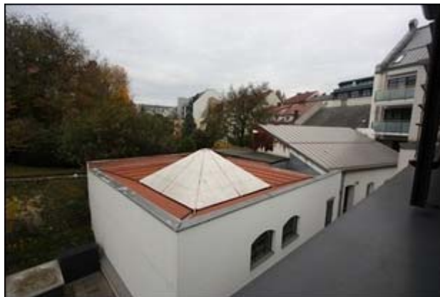
Abb.91 Ansicht Aussicht von einem nordseitigen Fenster (2.OG) auf den Anbau entlang der nördlichen Grundgrenze (Restaurant)
