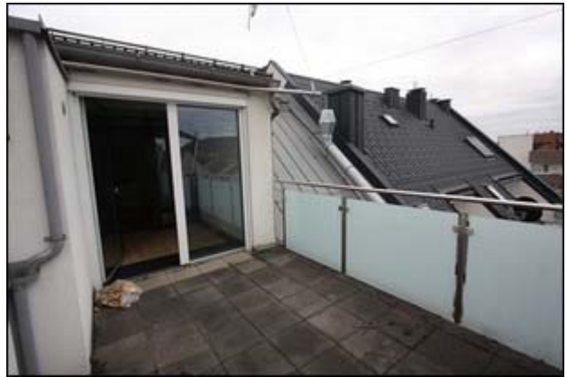
Abb.64 Ansicht Dachterrasse (Empore)
