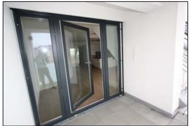
Abb.32 Ansicht Terrasse (DG)
