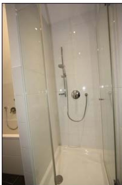
Abb.42 Ansicht Dusche, vgl. Abb.41
