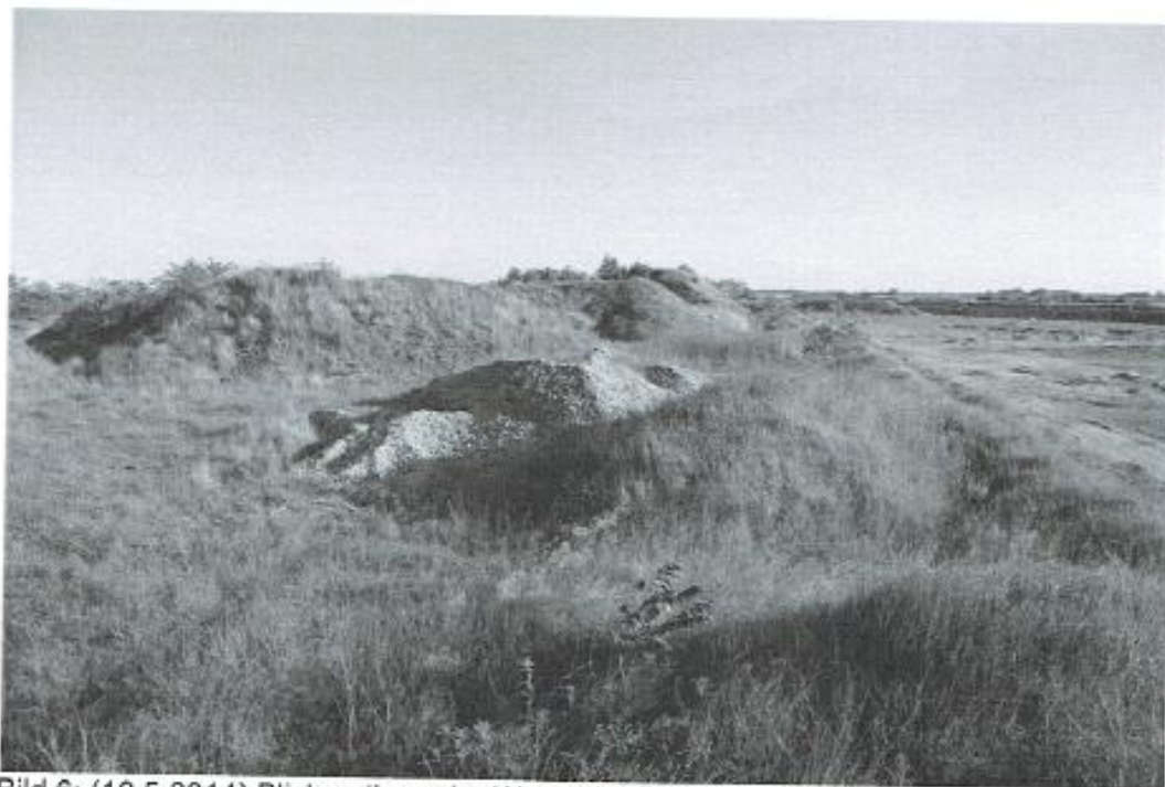
Bild 6: (19.5.2014) Blick entlang der Westseite Richtung Süden
