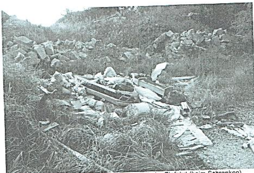
Bild 11: (30.10.2014) Fremdadlagerungen südlich der Einfahrt (beim Schranken)
