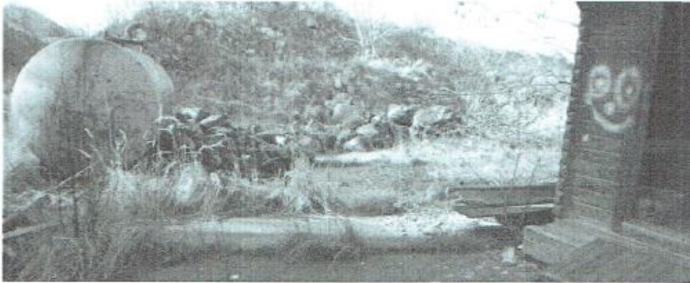
Foto 6: Zufahrt MITTE, Foto 7: Zufahrt MITTE Lagerungen
