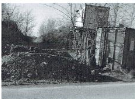
Foto 2: Zufahrt SÜD, Schranken gebrochen
