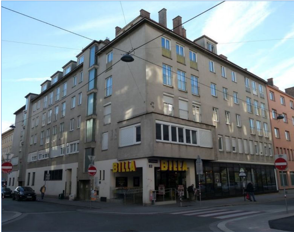
Ansicht Siebeneichengasse / Anschützgasse
