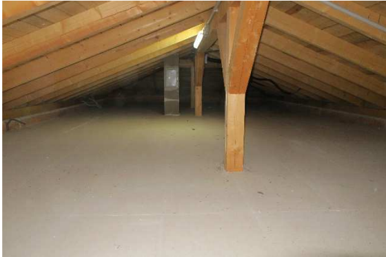
Rohdachboden über Wohnhaus
