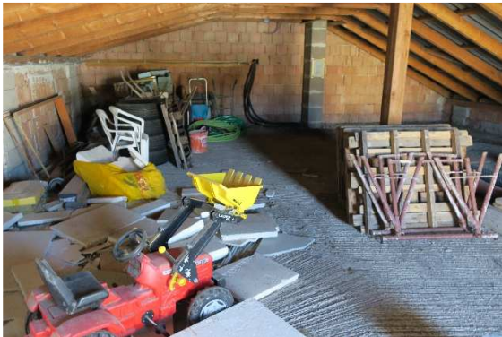
Rohdachboden über Nebengebäude
