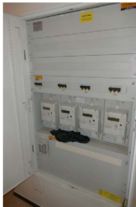
Strom-Stockwerksverteiler
