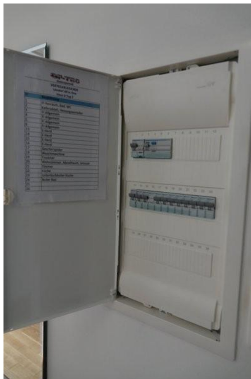
Abbildung 16 E-Verteiler
