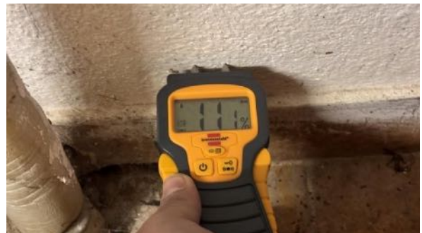
Feuchtemessung im Keller, minimale Feuchte
