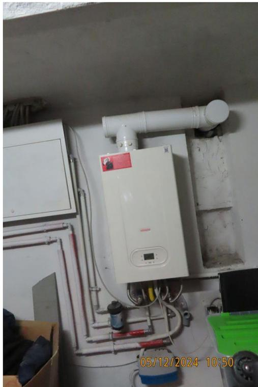
**Abb. 21: Gaszentralheizung mit Fußbodenheizungsverteiler**
