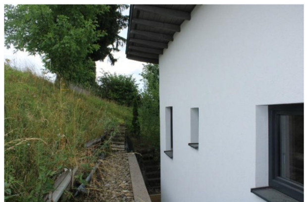
Wohnhaus Ansicht Rückseite (Norden)
