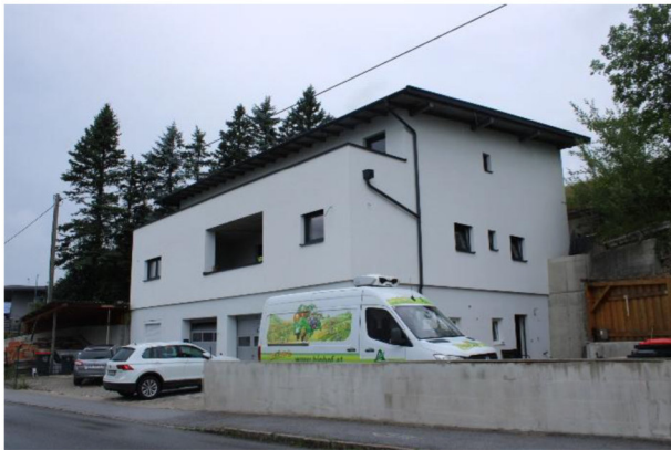
Wohnhaus Ansicht von Südost
