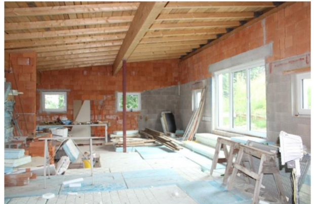
Rohbau im Dachgeschoß
