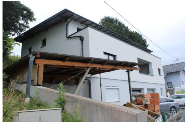
Wohnhaus Ansicht von Westen
