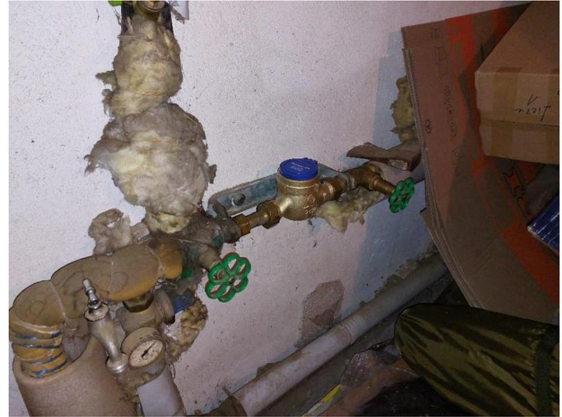
Abbildung 81: Wasseruhr / Hausanschluss
