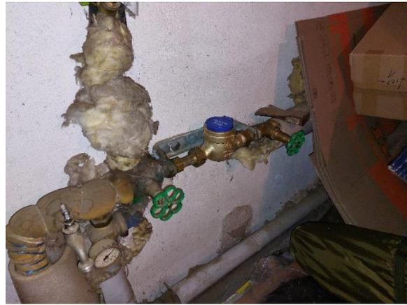
Abbildung 28: Wasserzähler / Hausanschluss
