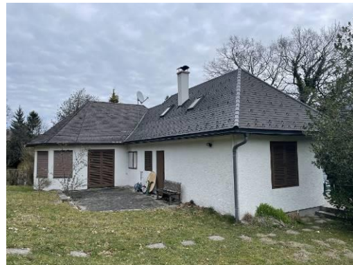
Südwestansicht des Wohnhauses
