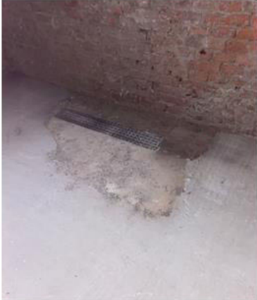
Lüftung von L2 zu L1 in Ordnung
