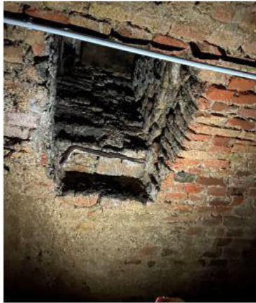
Öffnung im L2 zugemauert
