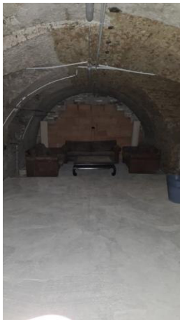
„Großer Raum“ – Richtung Abmauerung
