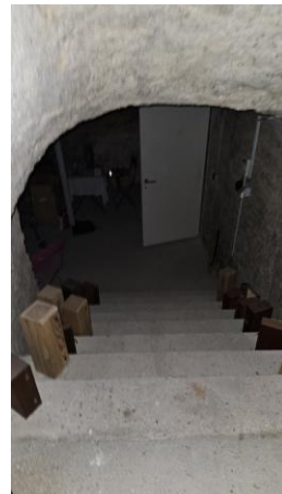
„Kleiner Raum“- Abgang oberer Bereich zu unterer Bereich
