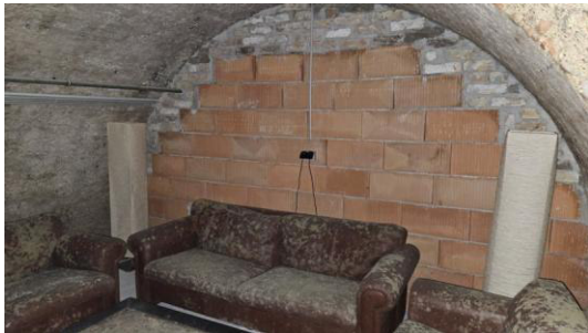
„Großer Raum“ – Abmauerung zu „Rest“
