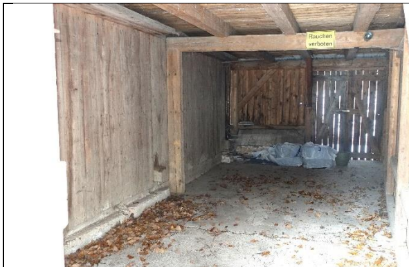
Lager: Boden: Beton; Wände: Bretterschalung; Decke: Holzbalkendecke mit Pfostenbelag;
