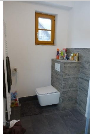
Waschraum/WC: Boden: Fliesen; Wände: teilweise Fliesen, teilweise verputzt und gemalt; Decke: verputzt gemalt;
