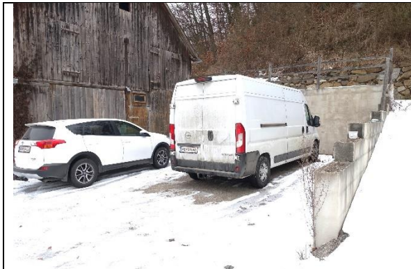
Freilager: Boden: Asphalt, auf 2 Seiten Betonhohlblockstützwand verputzt;
