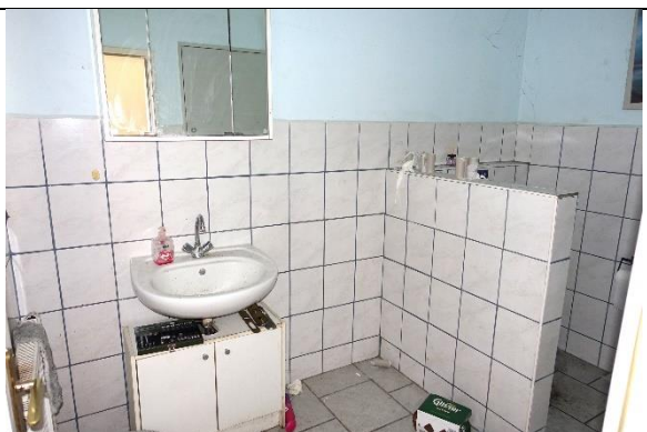
WC: Boden: Fliesen; Wände: Fliesen ca. 1,6 m hoch; restliche Wände und Decke: verputzt und gemalt; Sanitärausstattung: 1 Waschbecken mit Unterschrank, 1 Hänge-WC mit Unterflurspülkasten;
