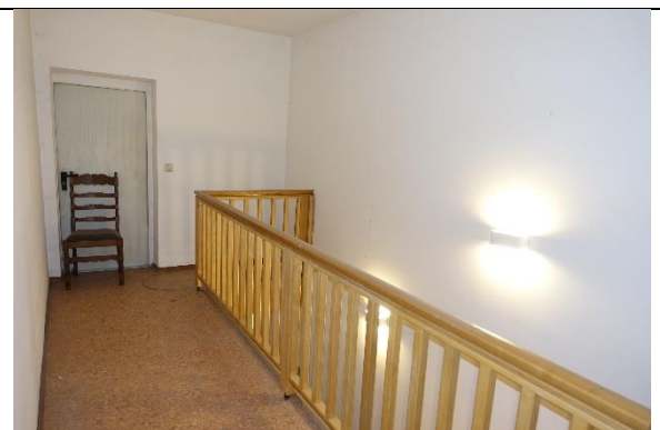
Vorraum: Boden: Kunststoffbelag; Wände und Decke: verputzt und gemalt;
