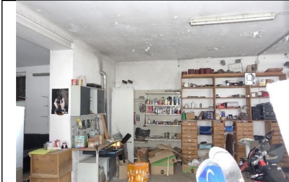
Garage-Werkstatt: Boden: Beton; Wände und Decke: verputzt und gemalt;
