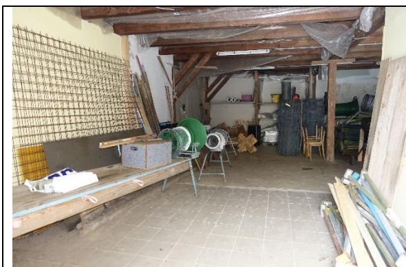
Lager Baustoffe: Boden: teilweise Beton, teilweise Fliesen; Wände: Gipskartonplatten ungespachtelt; Decke: Holzbalkendecke mit Bretterbelag;
