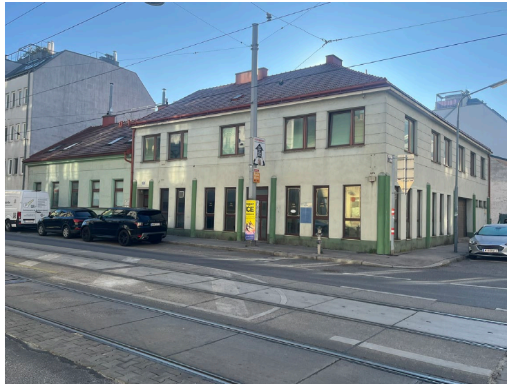
Abbildung 16: Ansicht des Bestandobjektes
