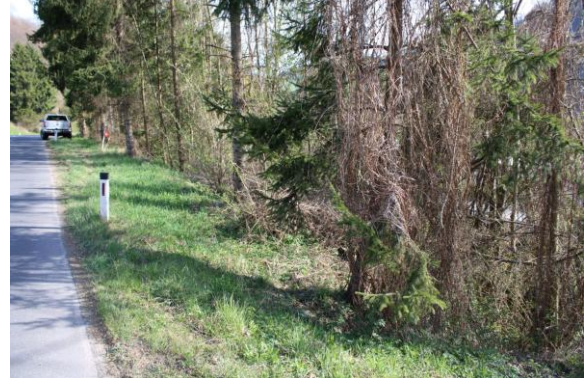
Bild 20: südlicher Grundstücksteil – Böschung bewaldet zur S35
