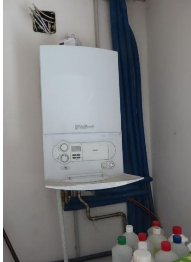
Abb. 35: Brennwertgerät
