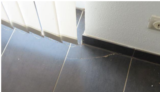
Abb. 40: Büro (Zubau) EG
