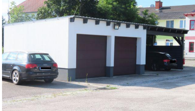
Abb. 28: Garage mit Carport
