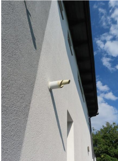
Abb. 29: Nicht ordnungsgemäße Abgasabführung für Brennwertgerät
