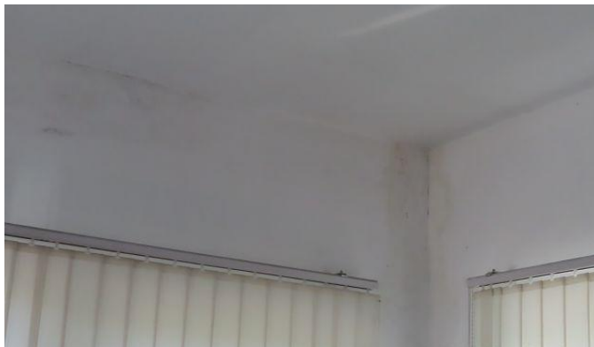
Abb. 39: Büro (Zubau) EG
