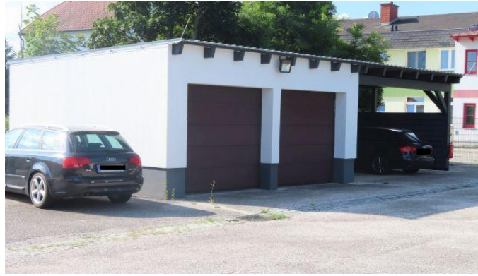
Abb. 26: Garage mit Carport
