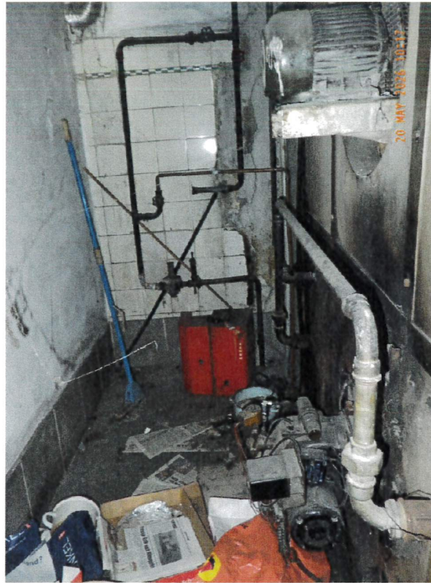
Rückseite des Backofens mit Zugang
