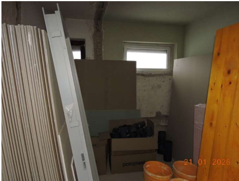
Bad und WC
