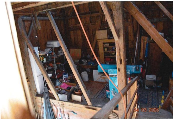
Schopf Dachboden Zugang über Zimmer SW
