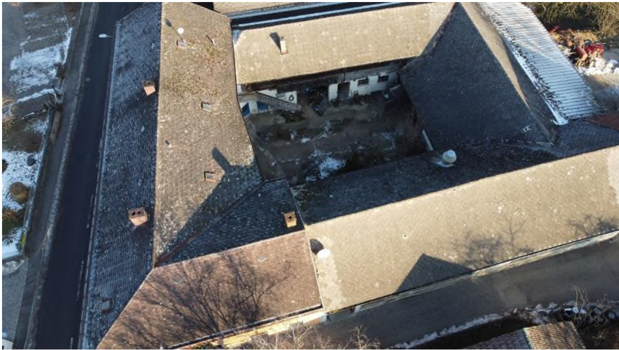
Diese Abbildung zeigt ebenso die Dachfläche des Hofes sowie die Nordseite des Innenhofes.
