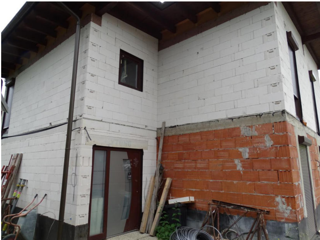
Bild 64 Zweiter Hauseingang an der Südwestseite zum neuen Stiegenhaus West
