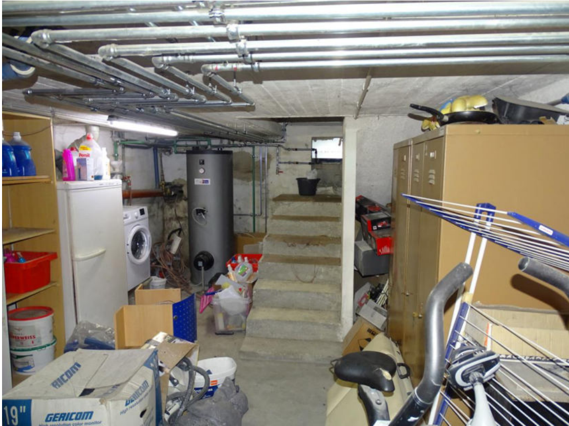
Bild 43 KG Altbau mit Stiegenabgang und Warmwasserboiler
