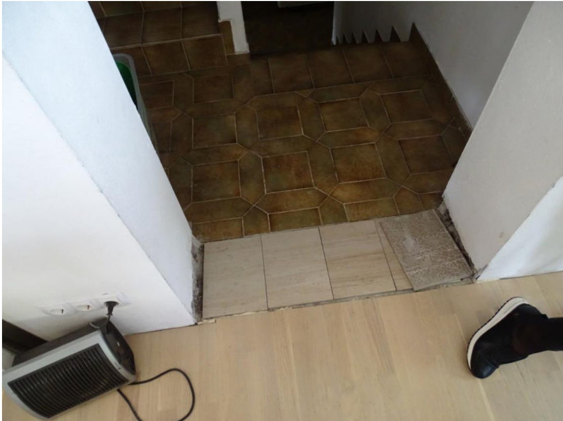
Bild 21 Verbindung beim Stiegenpodest zwischen Nordtrakt und Altbau
