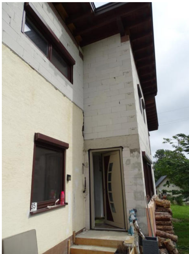
Bild 9 Hauseingang mit Zubau und aufgestocktem Altrakt
