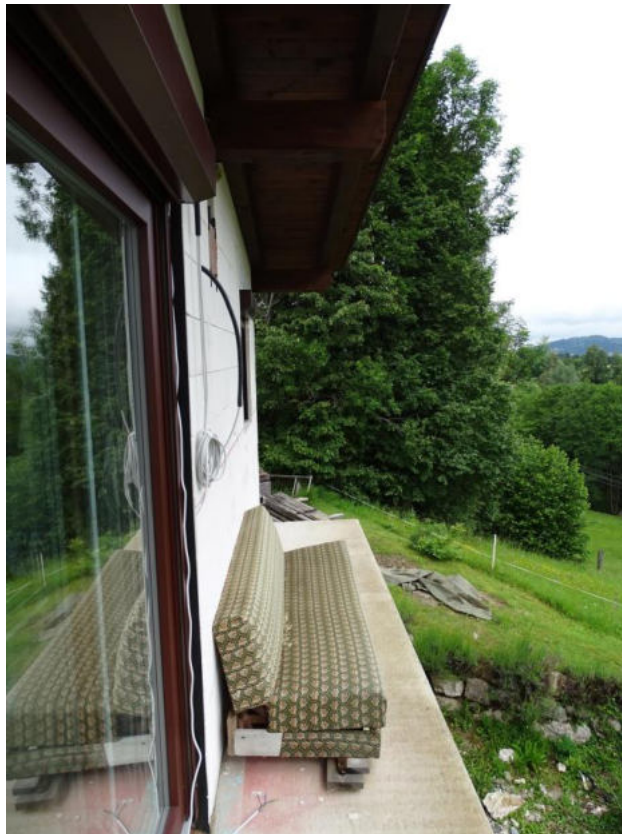
Bild 19 OG Balkon Nord
