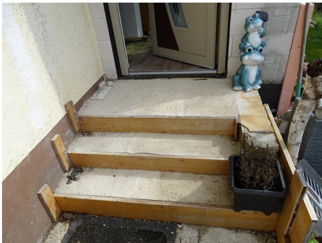
Bild 10 Hauszugang mit Außenstiege in Rohbau
