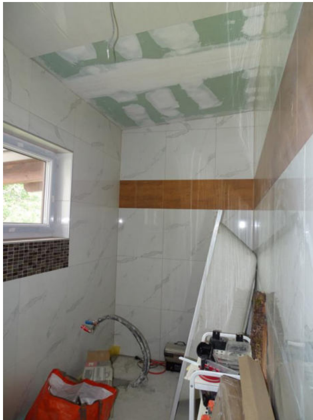
Bild 37 OG Badezimmer Rohbau
