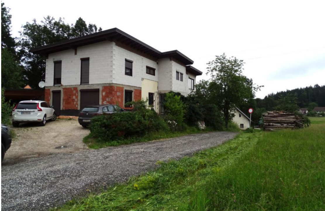
Bild 1 Gebäudeansicht Südostseite mit Grundstückszufahrt
