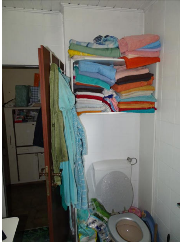
Bild 29 EG Badezimmer mit WC
