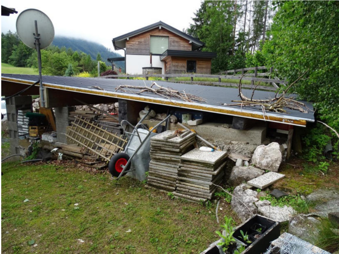
Bild 53 Flugdach vom Unterstellplatz Nordansicht mit Nachbargebäude im Hintergrund
