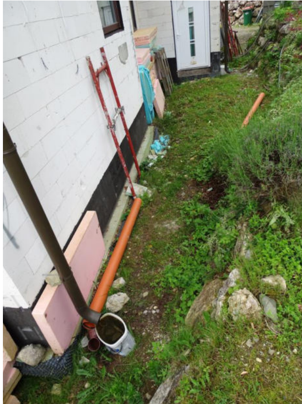
Bild 59 Traufenausbildung mit EG-Zugang zum westseitigen Stiegenhausanbau
