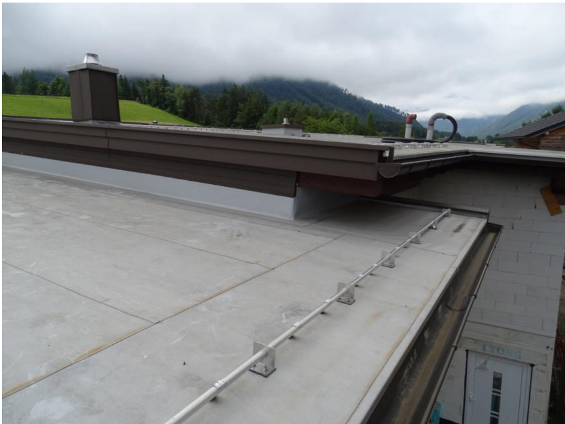
Bild 58 Traufenausbildung der neuen Pultdachkonstruktionen mit PVC-Foliendach
