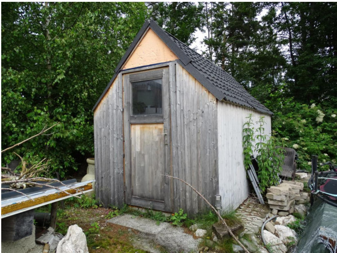
Bild 54 Saunaanlage Ansicht von der Nordostseite
