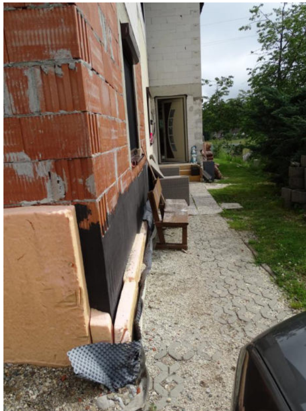
Bild 8 Gebäudezugang entlang der Ostseite mit Hauseingangstüre
