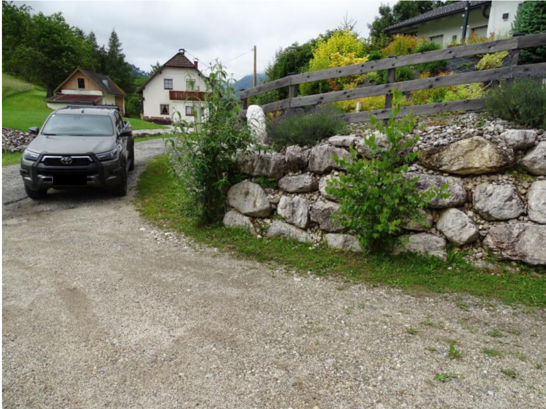
Bild 61 Steinschichtungsmauer entlang der südlichen Zufahrt
