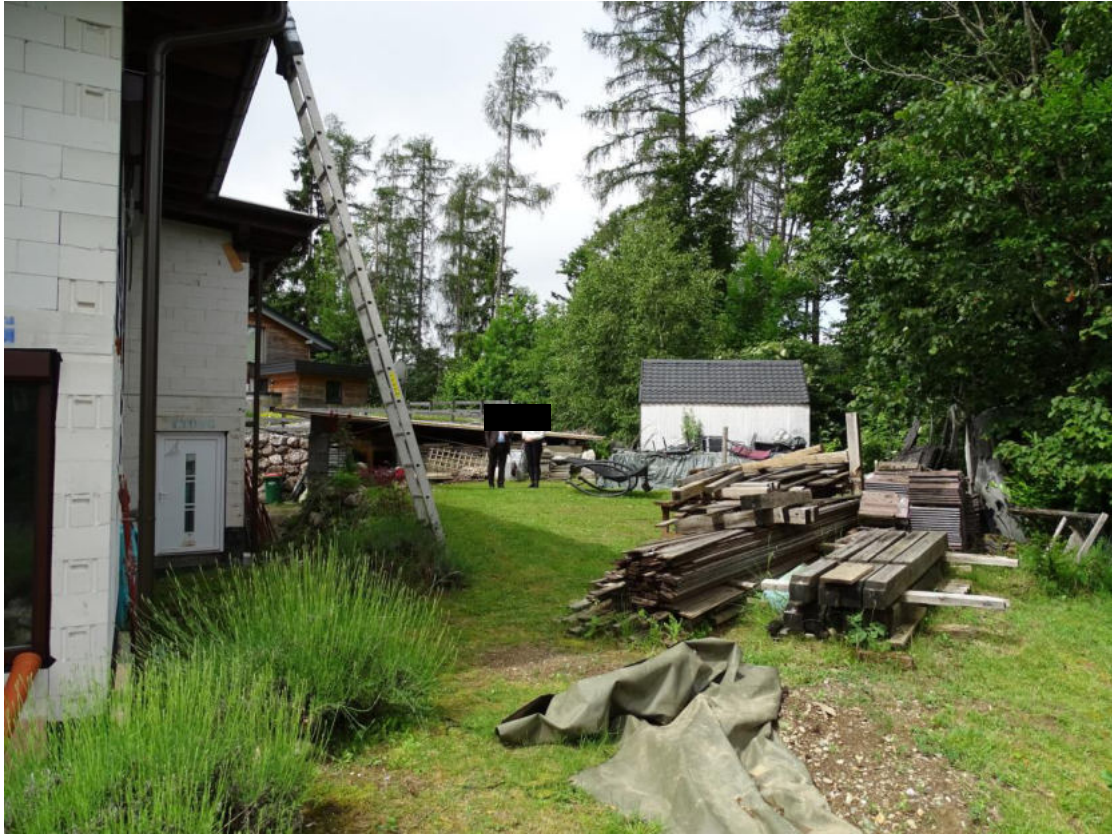
Bild 57 Bauholzablagerungen an der oberen Westseite des Hanggrundstücks
