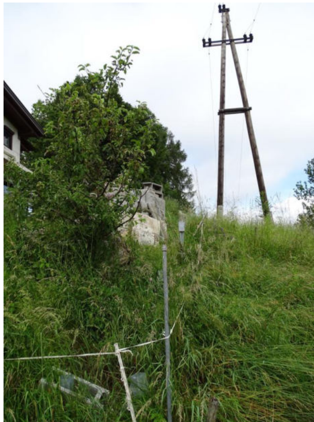
Bild 62 Stromverteilmast an der Nordseite der Grundstücksgrenze
