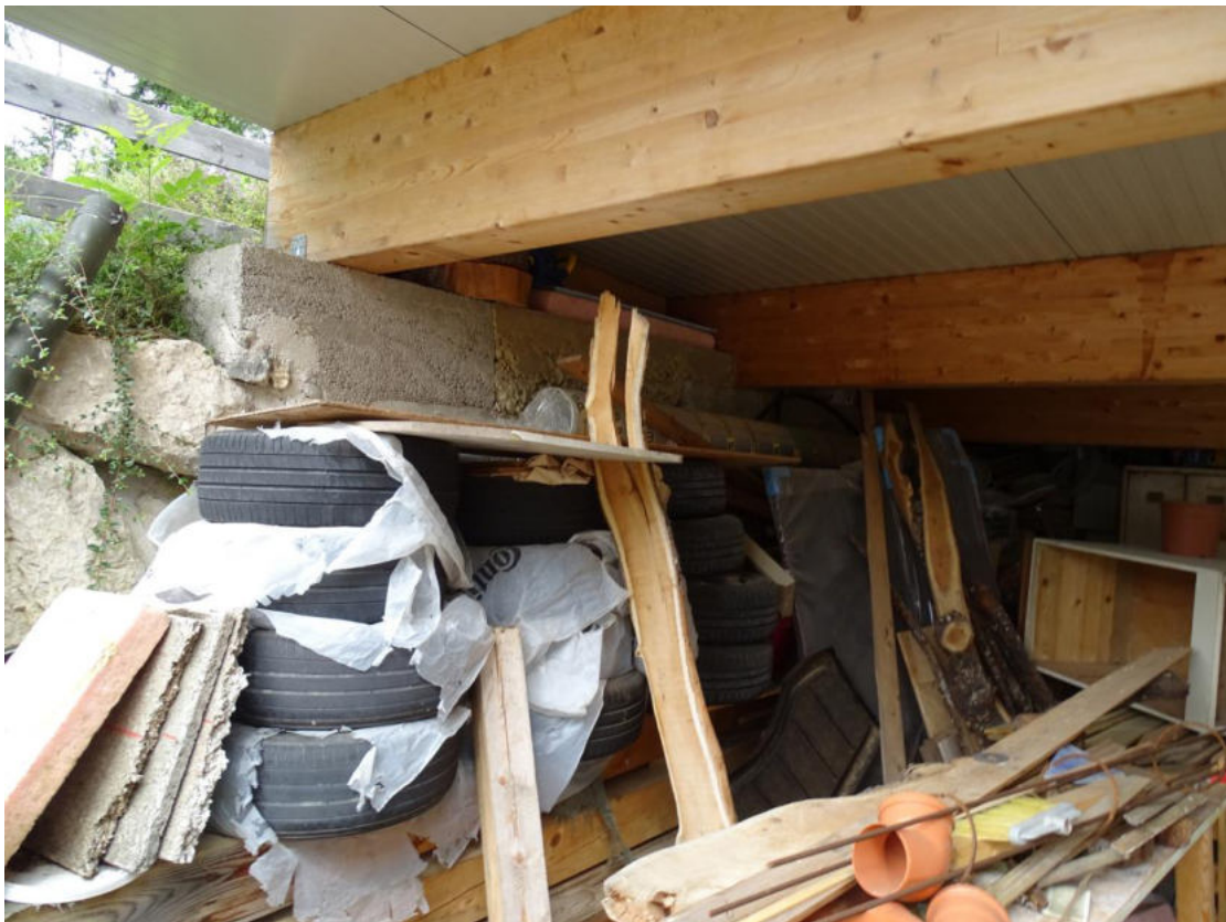
Bild 52 Stützwand beim KFZ-Unterstellplatz an der südlichen Nachbarschafts-Grundstücksgrenze
