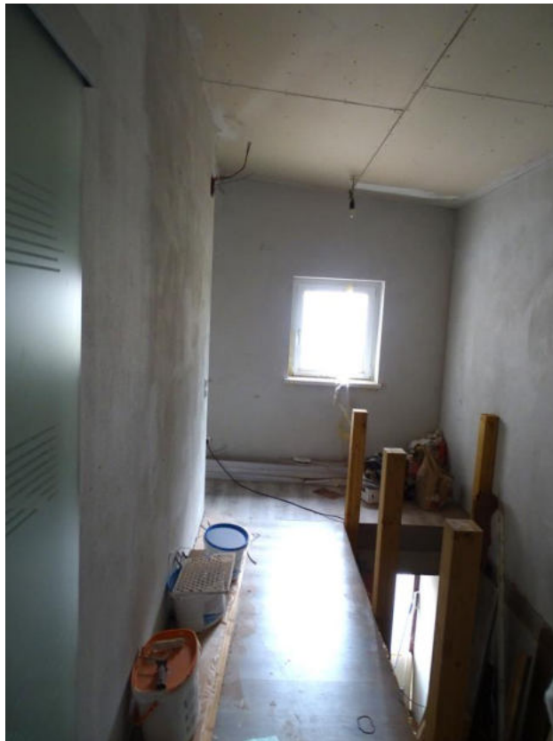
Bild 31 OG Stiegenhaus mit Fenster an der Südseite (Treppe fehlt noch!)
