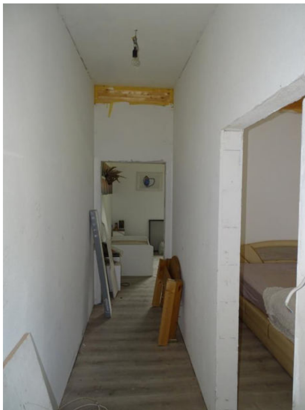
Bild 32 OG Zugang zu den Schlafräumen im 2021 aufgestockten Südtrakt
