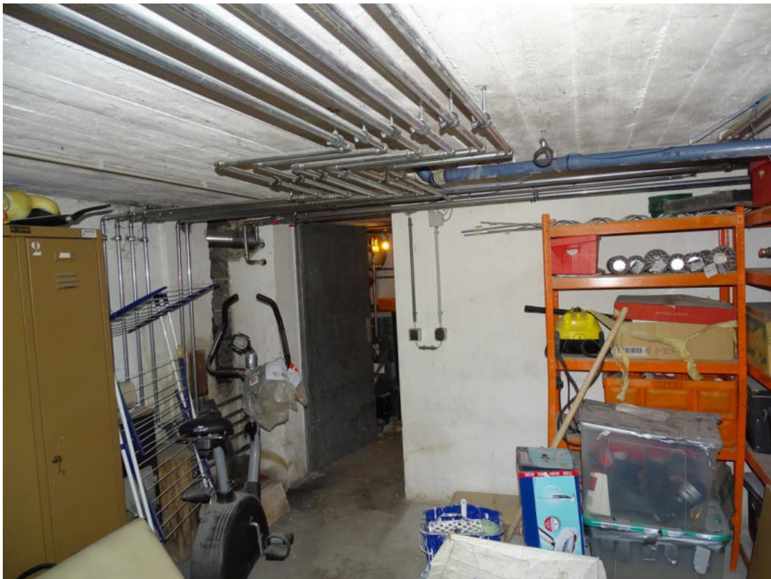
Bild 44 KG Altbau mit Zugang zum Heizraum und Pelletslager an der Südseite
