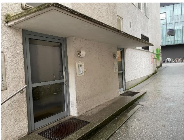
Bild 3 von 16 Blick auf den Zugangsbereich
