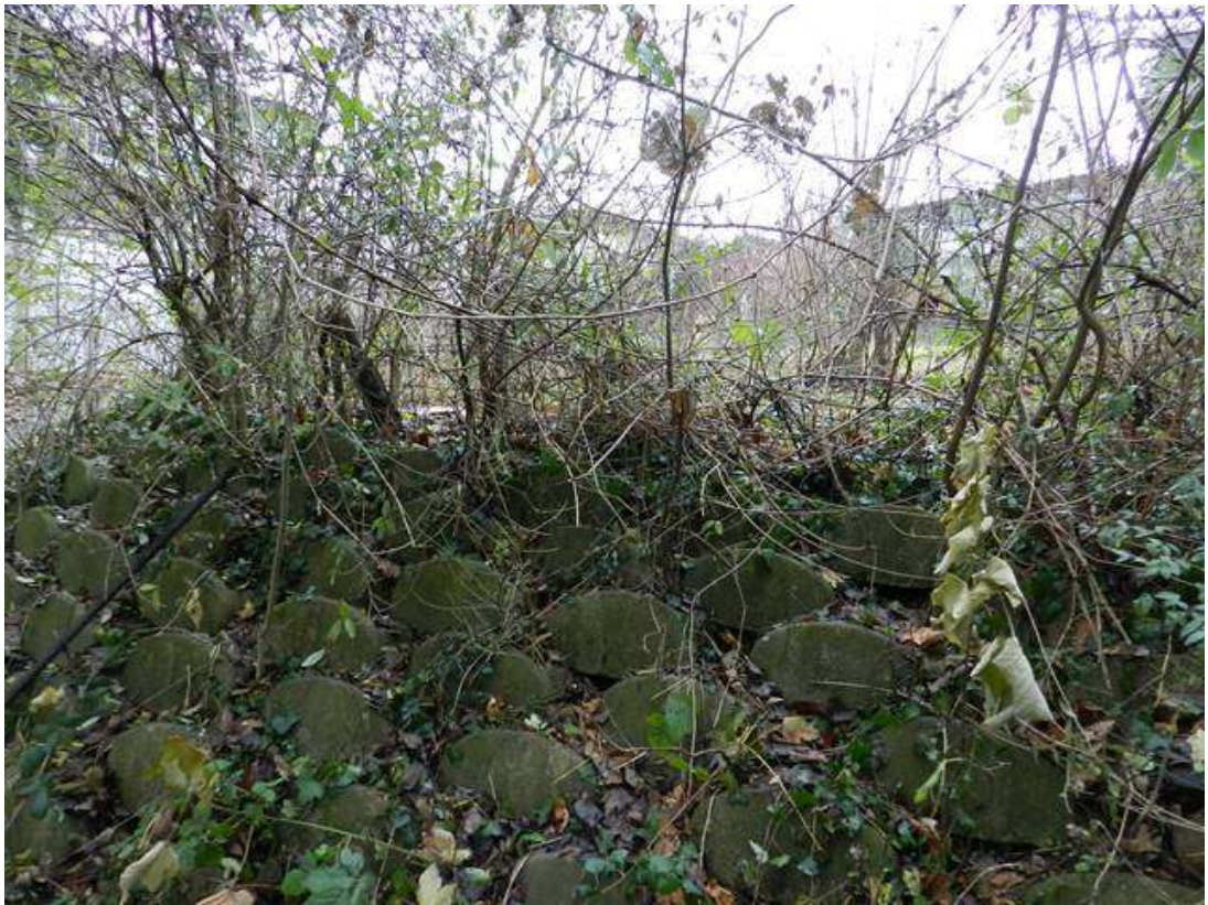
Terrasse mit Betonsteinen befestigt
