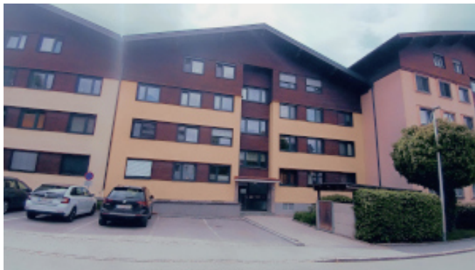
Hauseingang von der Hans Kappachstrasse
