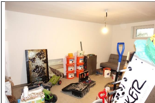
Lager 2: Boden Fliesen; Außenwände: Stahlbeton geweißt, Zwischenwände: verputzt und gemalt; Decke: Stahlbetonfertigteildecke;
