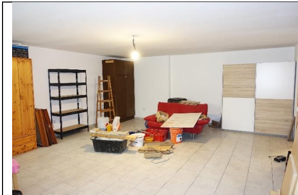
Abstellraum: Boden Fliesen; Außenwände: Stahlbeton geweißt, Zwischenwände: verputzt und gemalt; Decke: Stahlbetonfertigteildecke;
