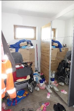
Schleuse: Boden: Fliesen; Wände und Decke: verputzt und gemalt; 1 elektrischer Handtuchheizkörper
