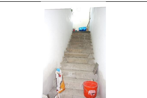
Treppe Keller/Doppelgarage: einläufige Betontreppe ohne Belag und ohne Handlauf;
