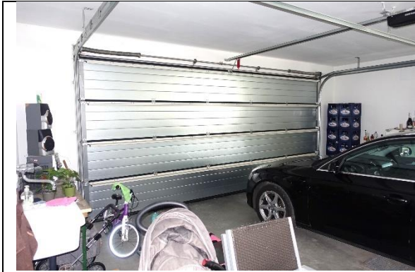
Doppelgarage: Boden: Beton versiegelt; Wände: verputzt und gemalt; Decke: Stahlbetonfertigteildecke; Sanitärausstattung: 1 Waschbecken mit Armatur;
