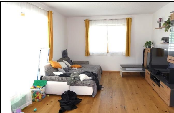
Wohnzimmer: Boden: Parkettboden; Wände und Decke: verputzt und gemalt;
