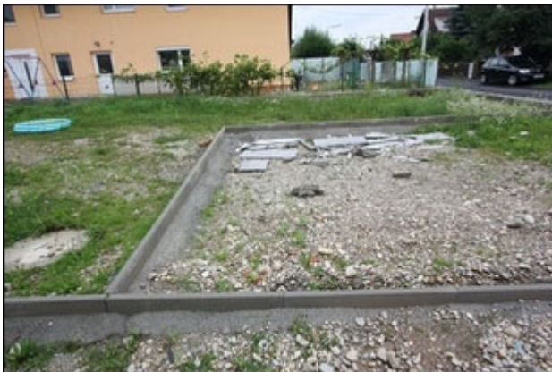
Abb.97 Ansicht Lage geplanter Abstellplatz KFZ 1 (vgl. Vorplatz, Abb.4)
