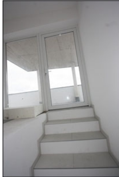
Abb.40 Ansicht Reihenhaus Top 1, Stiege OG/Dachterrasse
