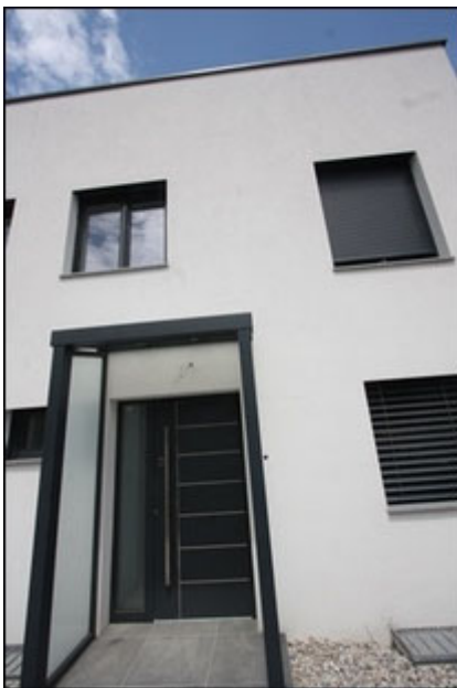
Abb.15 Ansicht Reihenhaus Top 1, Hauseingang
