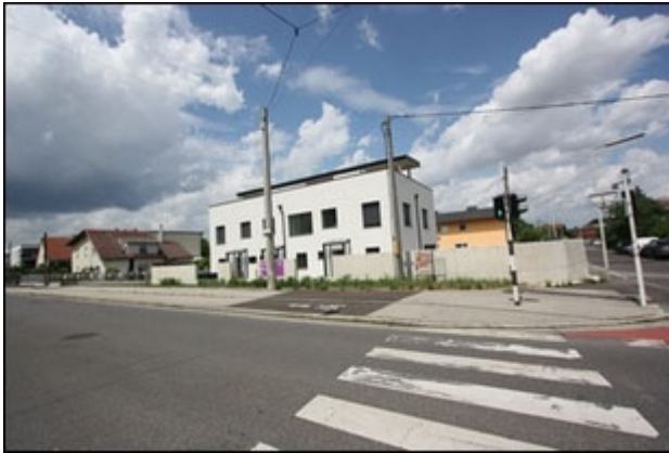
Abb.1 Ansicht Liegenschaft straßenseitig, Südostseite (Dauphinestraße/Ecke Holzingerstraße)
