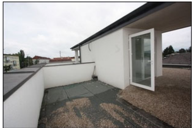
Abb.86 Ansicht Reihnhaus Top 2, Dachterrasse
