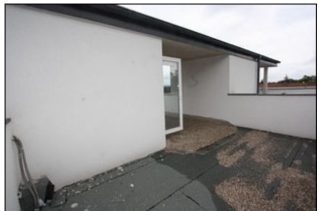
Abb.88 Ansicht Reihnhaus Top 2, Dachterrasse
