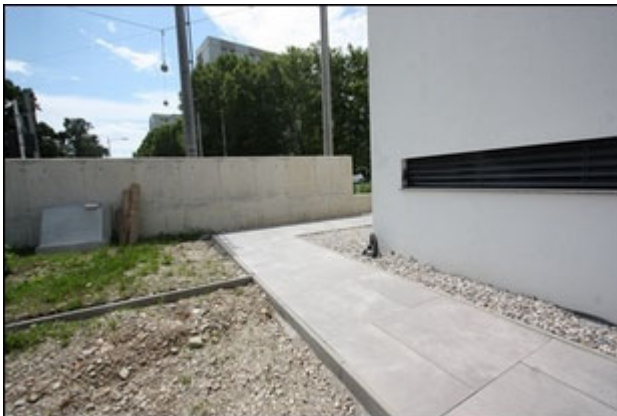
Abb.9 Ansicht Zugang an der Ostseite zu den Hauseingängen Begrenzungsmauer entlang Straßenfront
