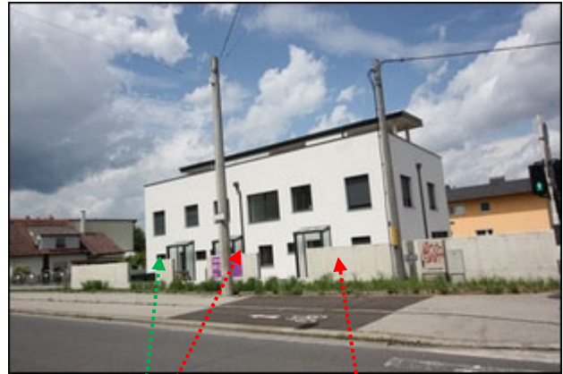
Abb.2 Ansicht Detail zu Abb.1 Reihenhaus Top 1* (Mittelhaus Holzingerstr. 44a Reihenhaus Top 2 (Endlage Ost, Holzingerstr. 44) Reihenhaus Top 3 (Endlage West, Holzingerstr. 44b = FREMDEIGENTUM
