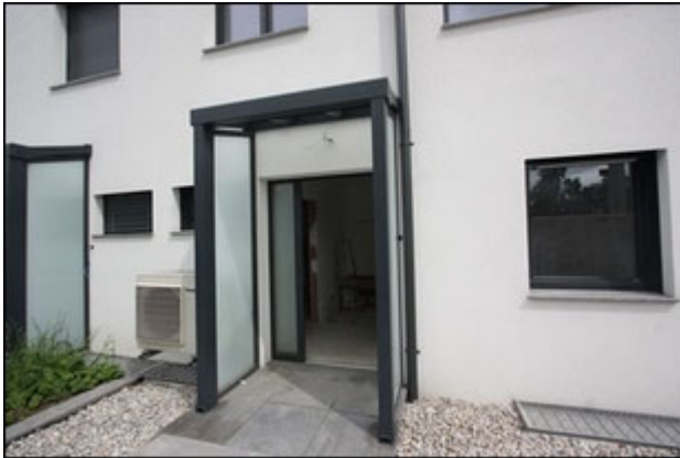
Abb.57 Ansicht Reihenhaus Top 2, Hauseingang
