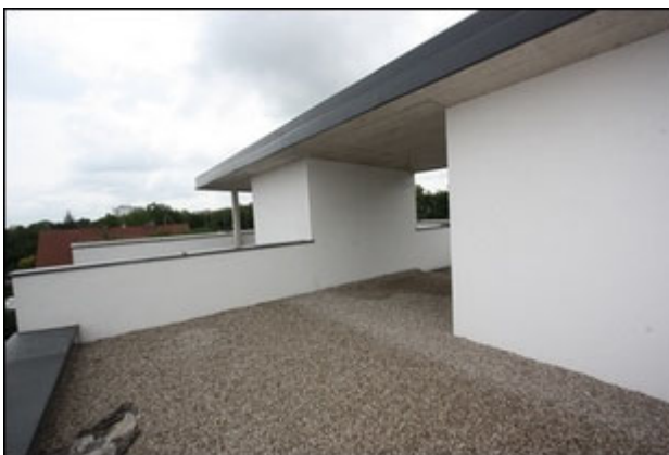
Abb.87 Ansicht Reihnhaus Top 2, Dachterrasse
