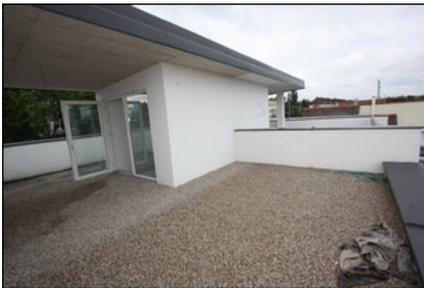
Abb.85 Ansicht Reihnhaus Top 2, Dachterrasse
