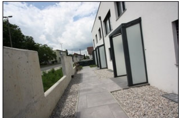
Abb.10 Ansicht Zugang an der Südseite zu den Hauseingängen Begrenzungsmauer entlang Straßenfront
