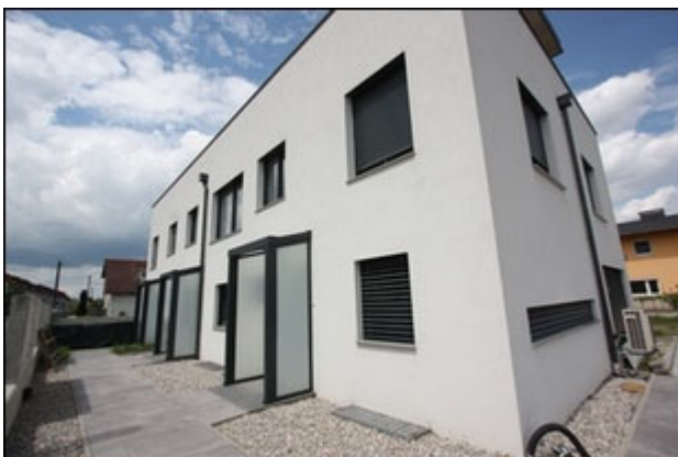
Abb.11 Ansicht Reihenhäuser Südseite (3 Hauseingänge)
