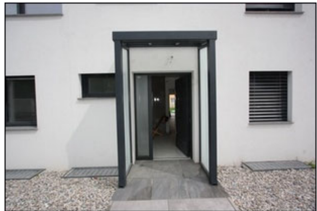
Abb.16 Ansicht Reihenhaus Top 1, Hauseingang
