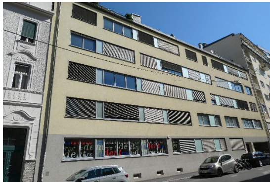
Straßenansicht von Südwesten
