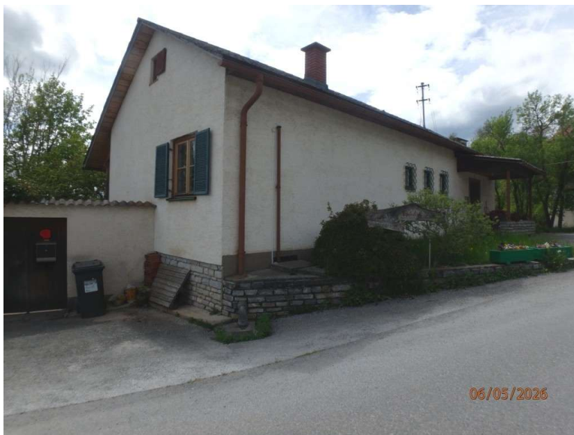
Fotos vom 06.05.2026 (Objekt versperrt)
