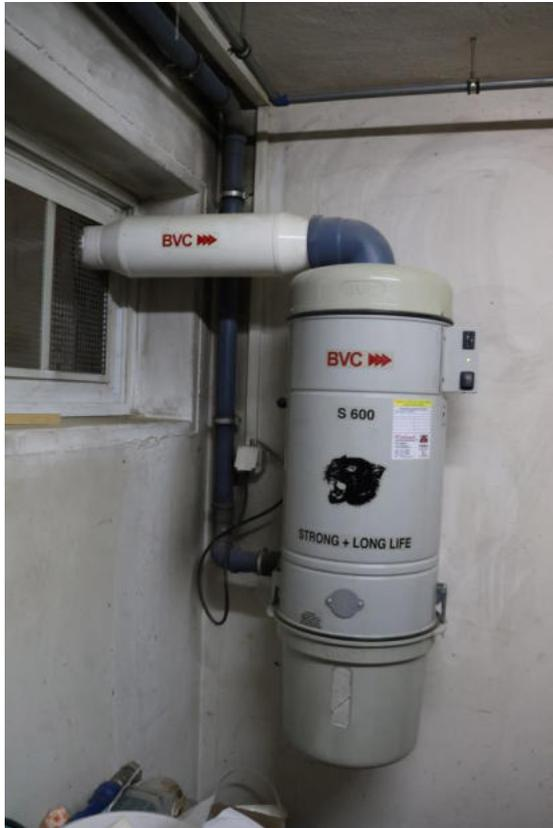
**Bild 38 Staubsauganlage im KG**
