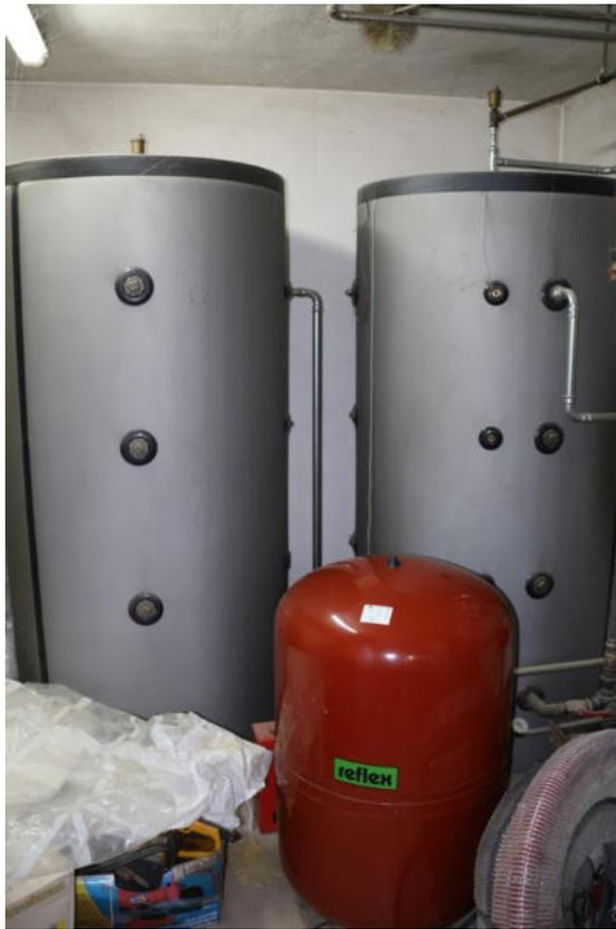
**Bild 37 Warmwasser-Pufferspeicher Solarkraft mit 4 Solarelementen am Hausdach**
