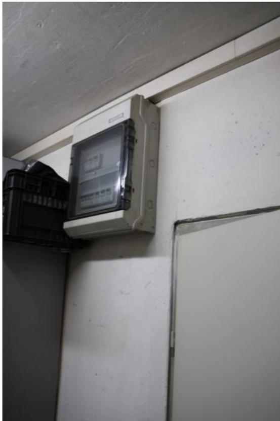
**Bild 35 E-Subverteiler im KG**
