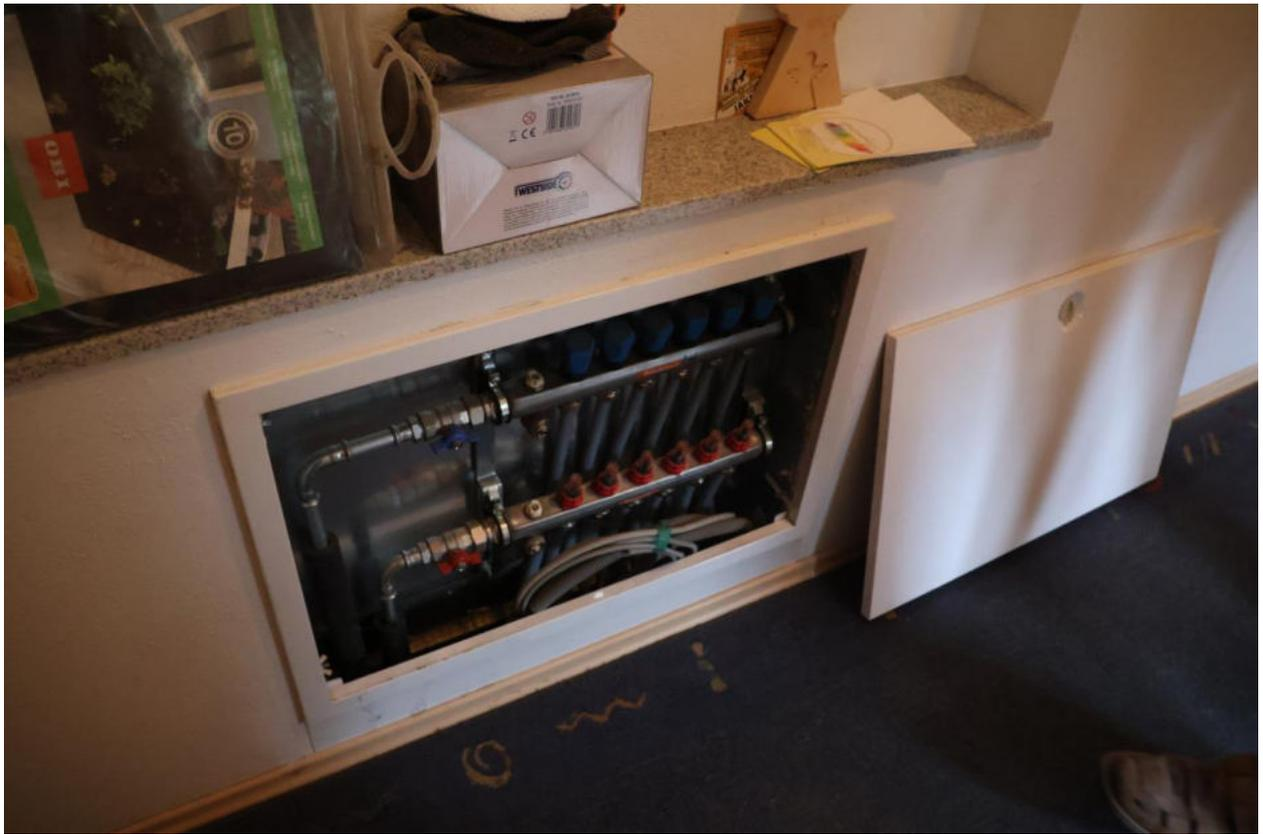
**Bild 17 Fußbodenverteileranlage im EG Flur**
