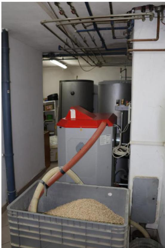
**Bild 36 KG Heizraum mit Pellets-Zentralheizungskessel**
