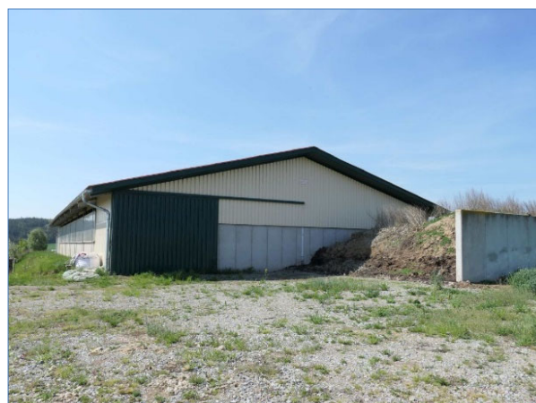
Halle west - nordseitig mit Düngerstätte
