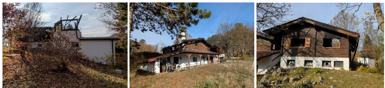
Abbildung 30: Fotodokumentation Hauptgebäude zum aktuellen Stichtag, Befundaufnahme am 11.11.2025
