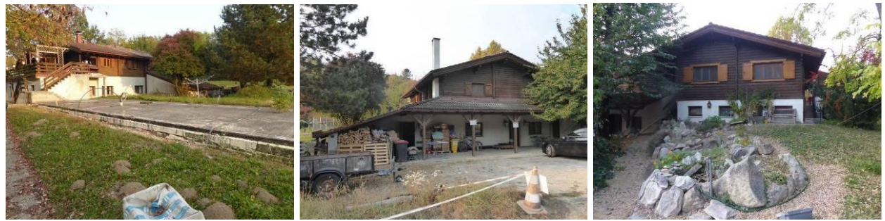
Abbildung 29: Fotodokumentation Hauptgebäude von der Befundaufnahme am 18.10.2018 zum Gutachten vom 23.01.2019 des SV Dipl.-Ing. Martin M. Roth zu 3 E 2617/15a des BG Bruck/Leitha
