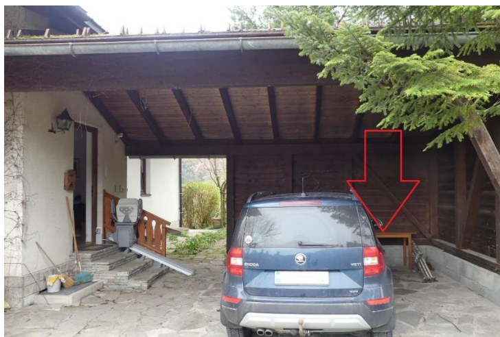
Hauseingang mit zugewiesenen Stellplatz (Pfeil)
