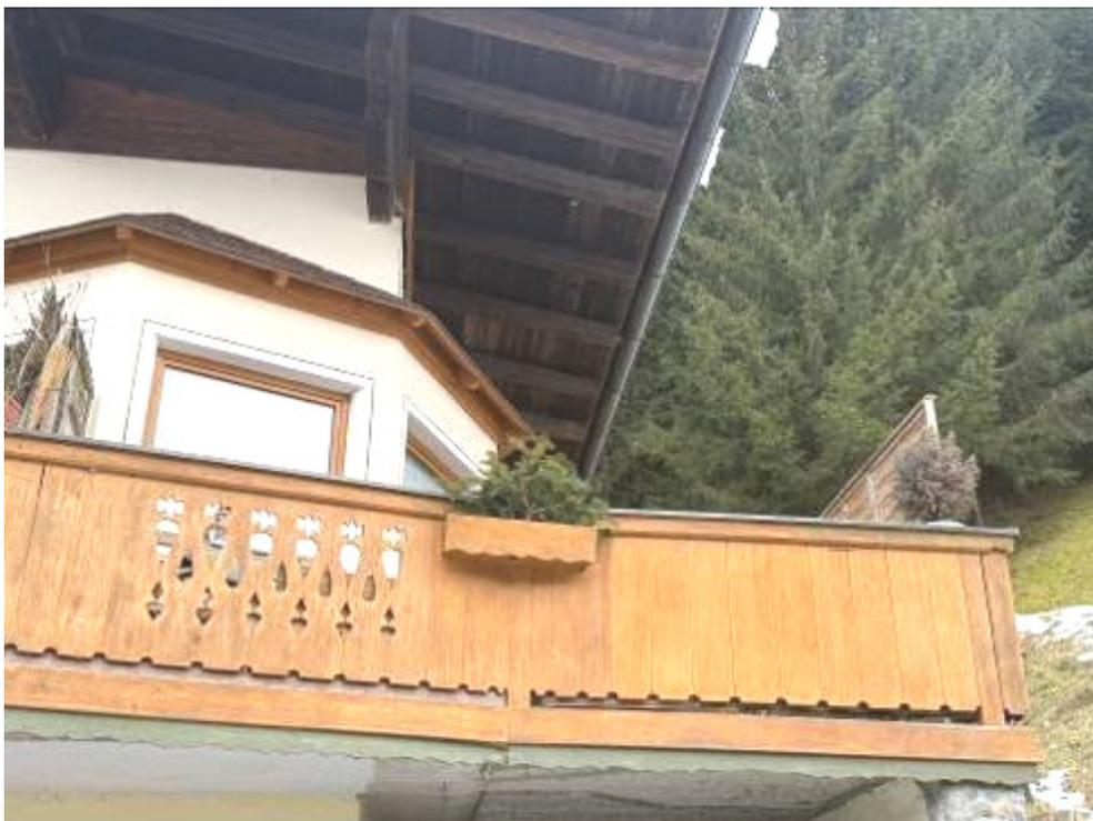
Ein Teil des Ober- und Dachgeschoßes ist mit Holz verschalt, das sehr abgewittert ist. Der gemauerte und gemalte Bereich des Erkers im Erdgeschoß ist mit Schindeln eingedeckt.
