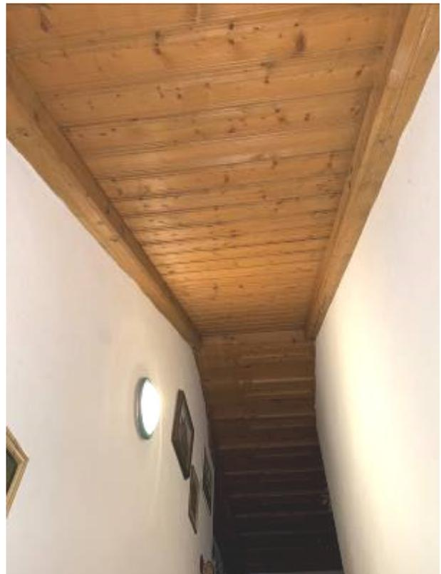
An die Stiege schließt im Erdgeschoß offen die Diele an, in der ein Fliesenboden verlegt ist. Die Wände sind verputzt und gemalt. An der Decke ist eine überluchte Holzdecke aufgebracht, deren Balken mit Schnitzereien gestaltet wurden.
