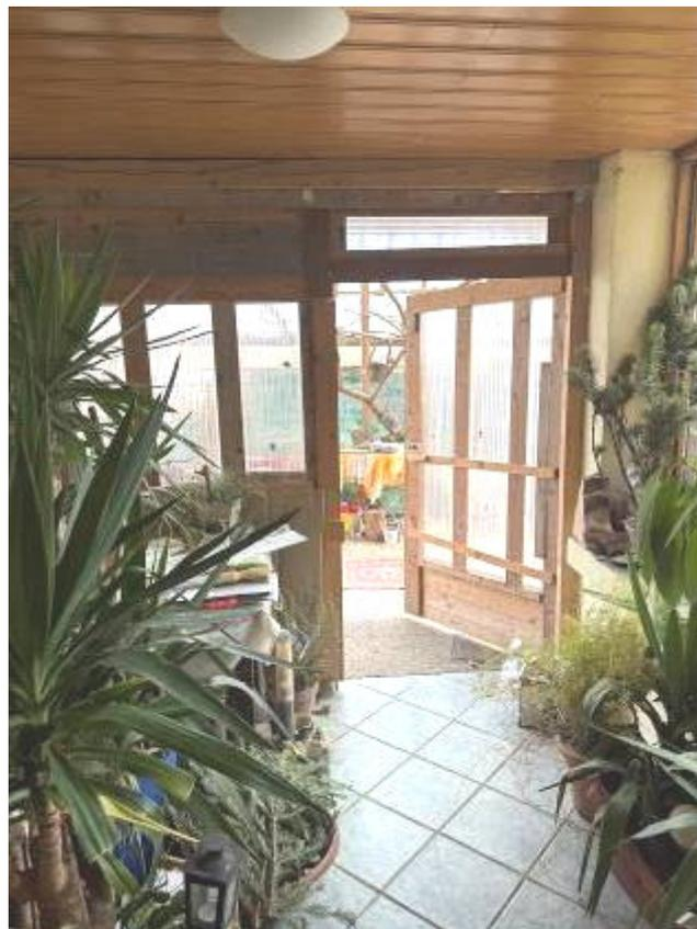
Im gesamten Vorraum- und Stiegenhausbereich sind Fliesen verlegt. Die Wände sind verputzt und gemalt. Auf die Decke ist eine einfache Holzschalung aufgebracht.
