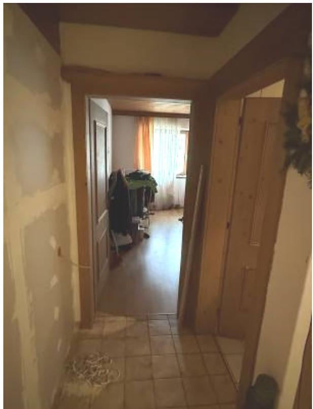
Die Türen im Erdgeschoß sind Futterstocktüren aus Holz mit aufgesetzten Gesimsen im Außenbereich. Die Holztüren mit Posthornrückern haben zwei Füllungen, die mit Profileisten eingefasst sind.
