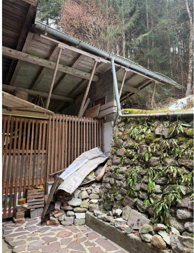
Die Ostwand des Erdgeschoßes ist bis zur Dachunterseite mit einfachen dünnen Holzschalungsbrettern verkleidet. Um die Fenster bestehen Holzrahmen.
