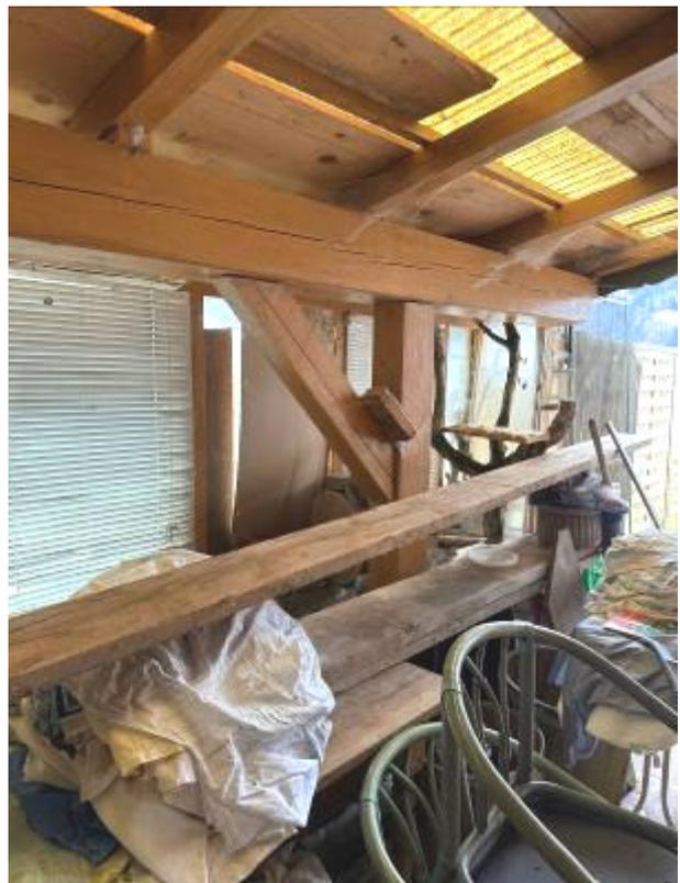
Im westseitigen Außenbereich wurden Fenster mit Holzrahmen und Einfachverglasung eingebaut. Der Wandbereich zum Wohnzimmer und zum südseitig anschließenden Zimmer ist im Außenbereich mit Holz verschalt.
