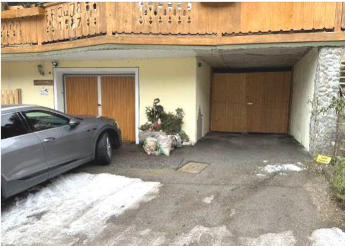
Seitlich an der Mauer, die mit Steinen verkleidet ist, bestehen Risse und Putzabplatzungen. Die Wände sind verputzt und gemalt. Der Boden ist asphaltiert.
