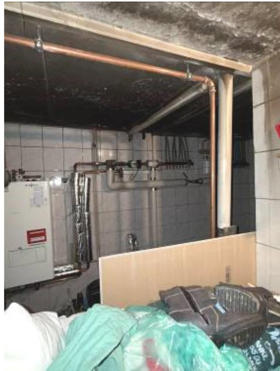
In diesem Bereich bestehen auch der Boiler und das Ausgleichsgefäß. Weiters besteht der Waschmaschinenanschluss und sind verschiedene Regale an den Wänden befestigt. Die Wände sind zum Großteil gefliest. Ostseitig ist ein Wandbereich verputzt. Die Betondecke befindet sich im Rohzustand. Südseitig besteht ein einfaches Holzfenster mit Holzverkleidung.
