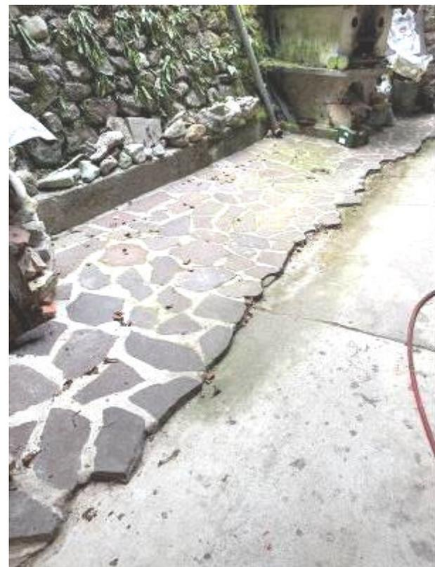
Der Betonboden hat an verschiedenen Stellen Sprünge und reicht bis zur südseitigen Hauswand. Im Bereich der Hauswand besteht ein betonierter Kellerschacht, der ca. 25 bis 30 cm höher ist als der Betonboden.
