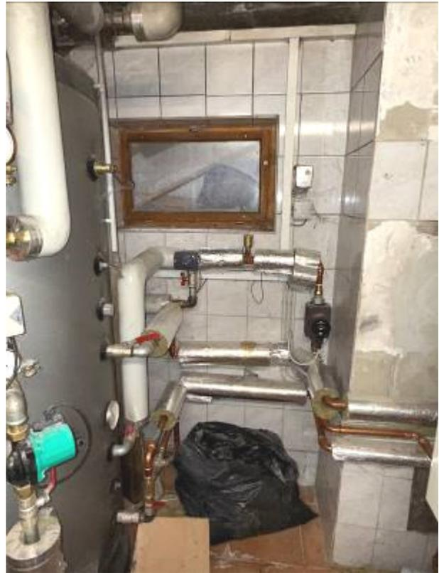
Es rinnt teilweise Wasser aus den Leitungen an der Wand. In diesem Bereich besteht auch die Gastherme. Der Boiler ist laut erteilter Auskunft undicht. Die Wände sind verfliest. Im Bereich der Gastherme fehlen an der Südwand die Fliesen.
