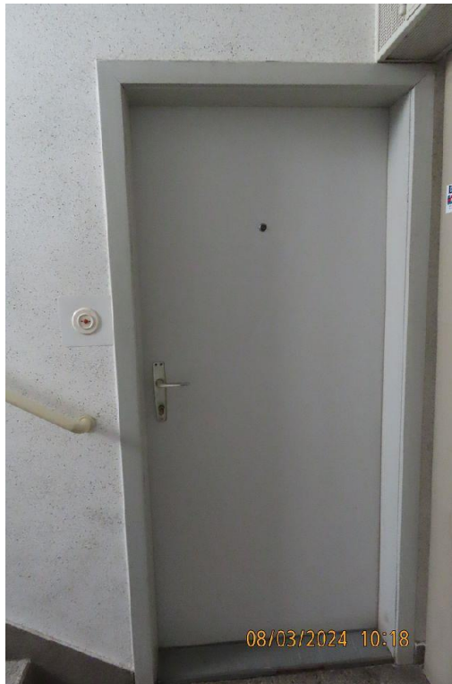
Abb. 34: Eingang Wohnungseigentum W 3 hofseitig (Stiegenhaus)
