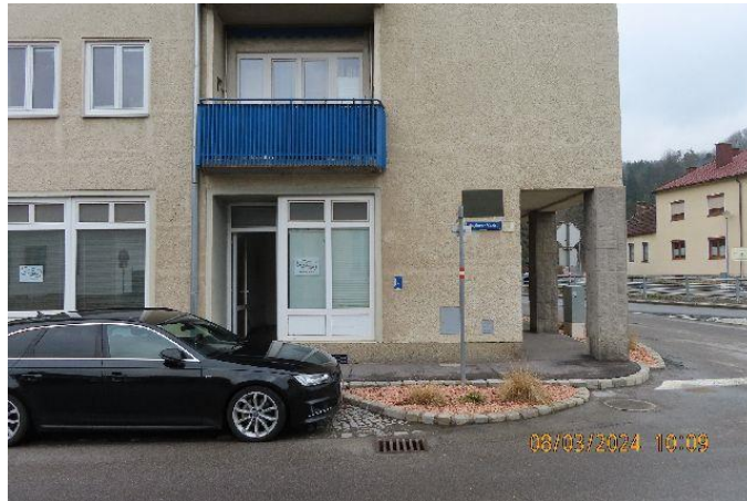
Abb. 29: Wohn- und Geschäftsgebäude Straßenansicht – Eingang straßenseitig Äußerer Markt
