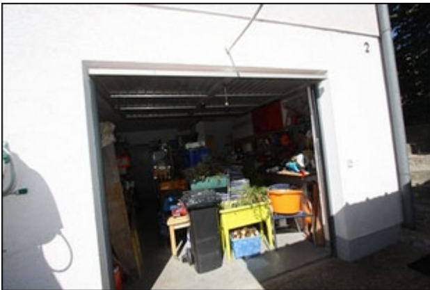
Abb.47 Ansicht Garage (vgl. Abb.7, 41/42)
