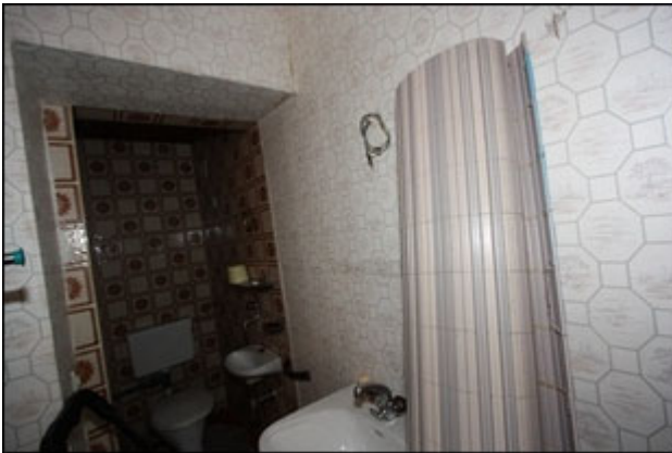
Abb.53 Ansicht ehem. Wohnraum KG, Waschbecken, Zugang WC
