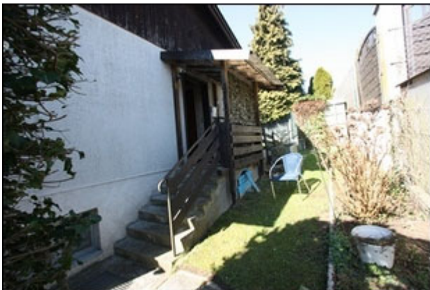
Abb.9 Ansicht Wohngebäude, Zugang Hauseingang
