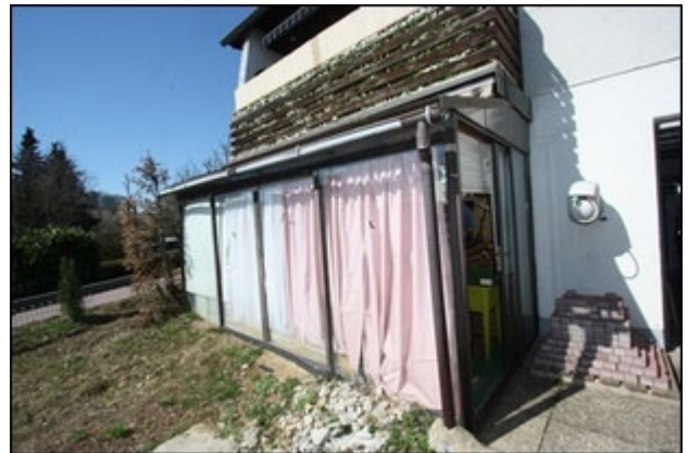
Abb.48 Ansicht Vorbau/Wintergarten (vor ehem. Wohnraum KG)
