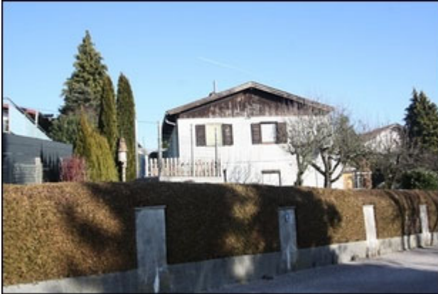
Abb.1 Ansicht Liegenschaft/Wohngebäude, Straßen-/Südseite
