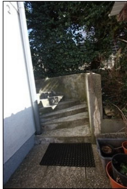
Abb.8 Ansicht Zugang Hauseingang
