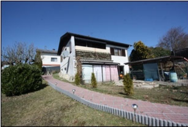
Abb.23 Ansicht Wohngebäude Südost, Garten
