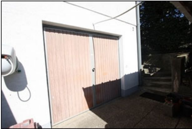
Abb.7 Ansicht Wohngebäude, Garagentor, Zugang Hauseingang
