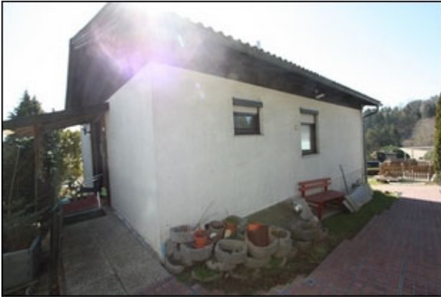
Abb.13 Ansicht Wohngebäude Nordwest
