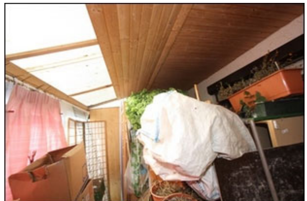
Abb.50 Ansicht Vorbau/Wintergarten (vor ehem. Wohnraum KG)
